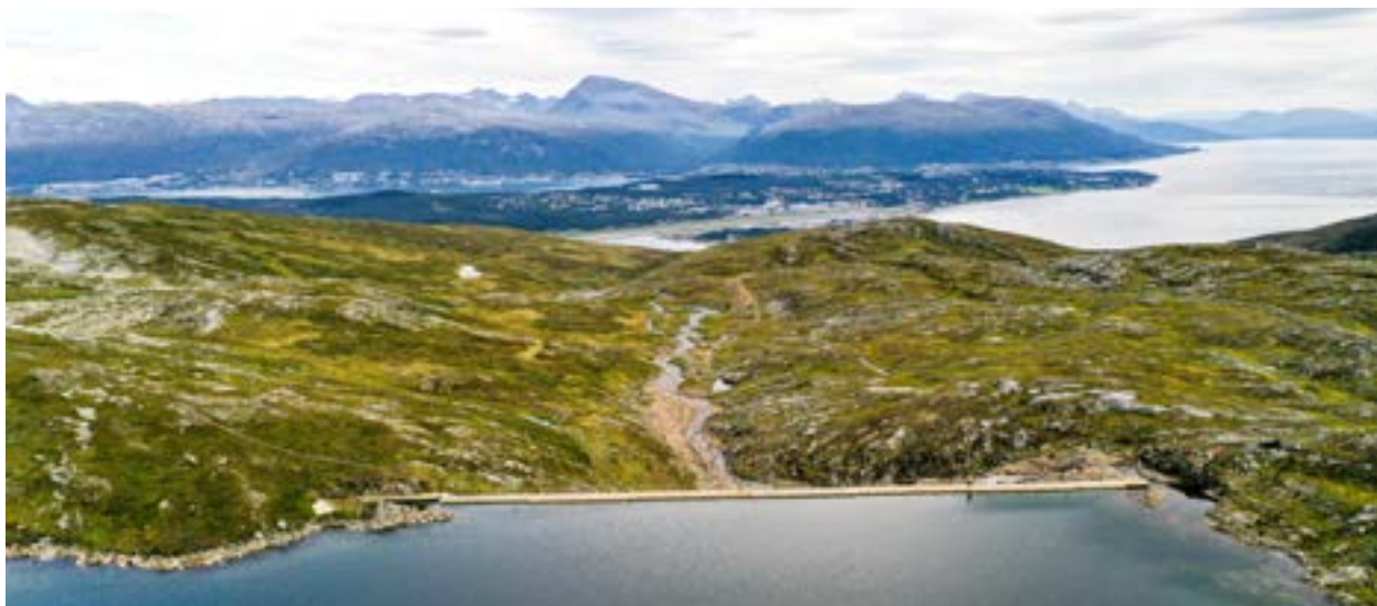
Amundvatnet vannverk på Kvaløya i Tromsø.
