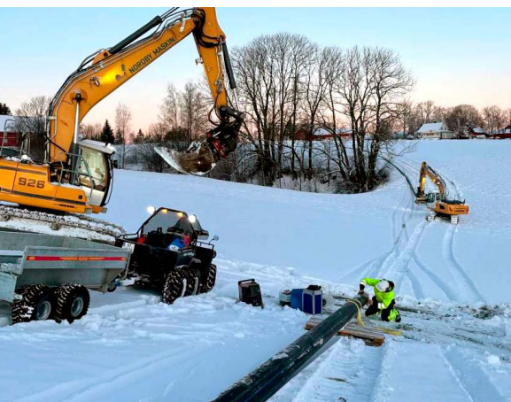
Legging av reservervannsledning. Foto: NRV IKS
