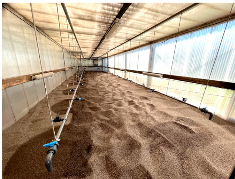
Figur 2: Spredesystem med dyser i forfilterhus (biofilter)
