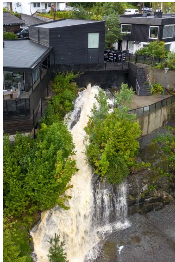
«Lille Hans» 27.8.2023 førte til store skader i Oslo. Dette gjaldt både vann i kjellere, vann på avveie og skader fra delvis lukkede bekker slik bildet viser. Foto: Hans Olav Torgersen
