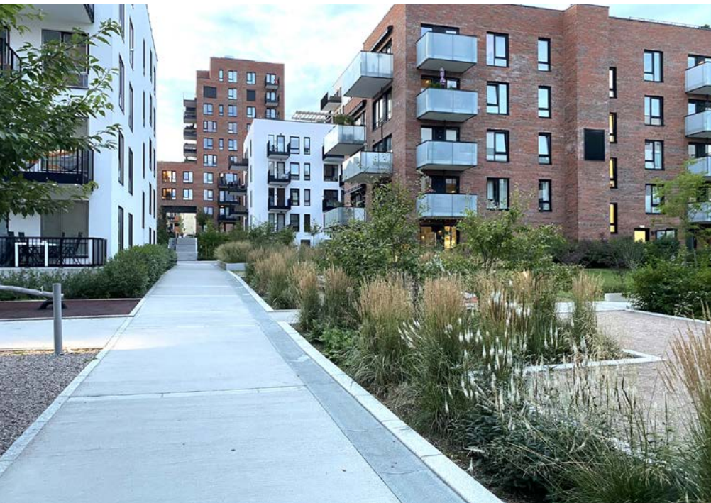
Forholdsvis ny utbygging og overvannshåndtering i Hasle, Oslo. Foto: Anine Drageset
