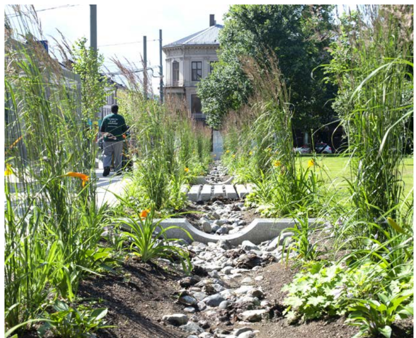
Vadi med fordrøying under bakken, knyttet til avrenning fra Thorvald Meyers gate i Oslo.
