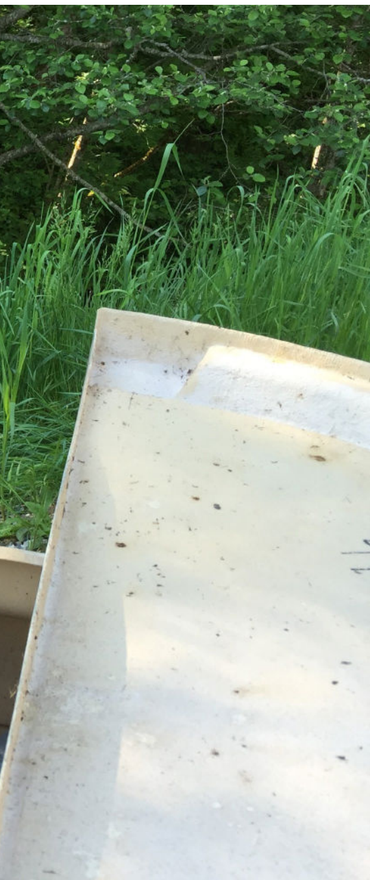
Her utføres service på et minirensanlegg. Foto: Norsk Vann
