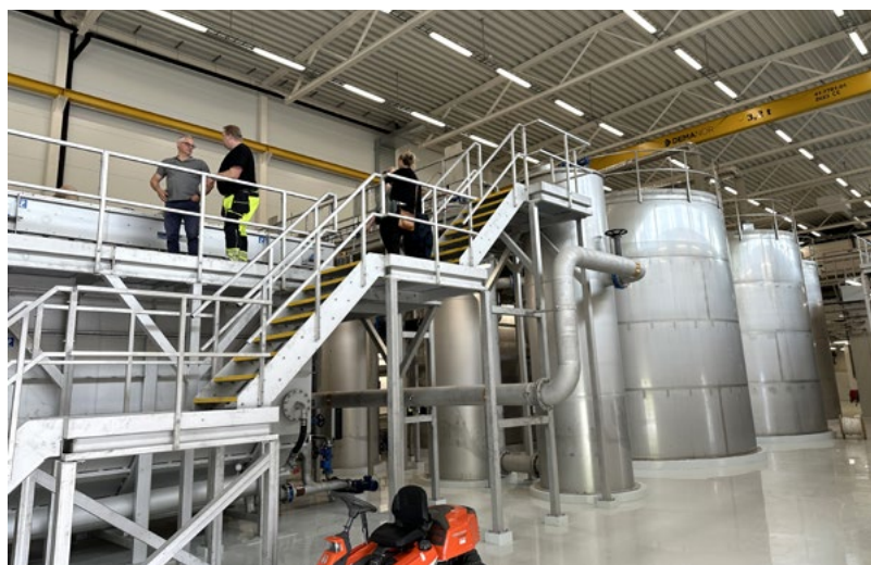
Tankene på anlegget er sveiset sammen på stedet.
