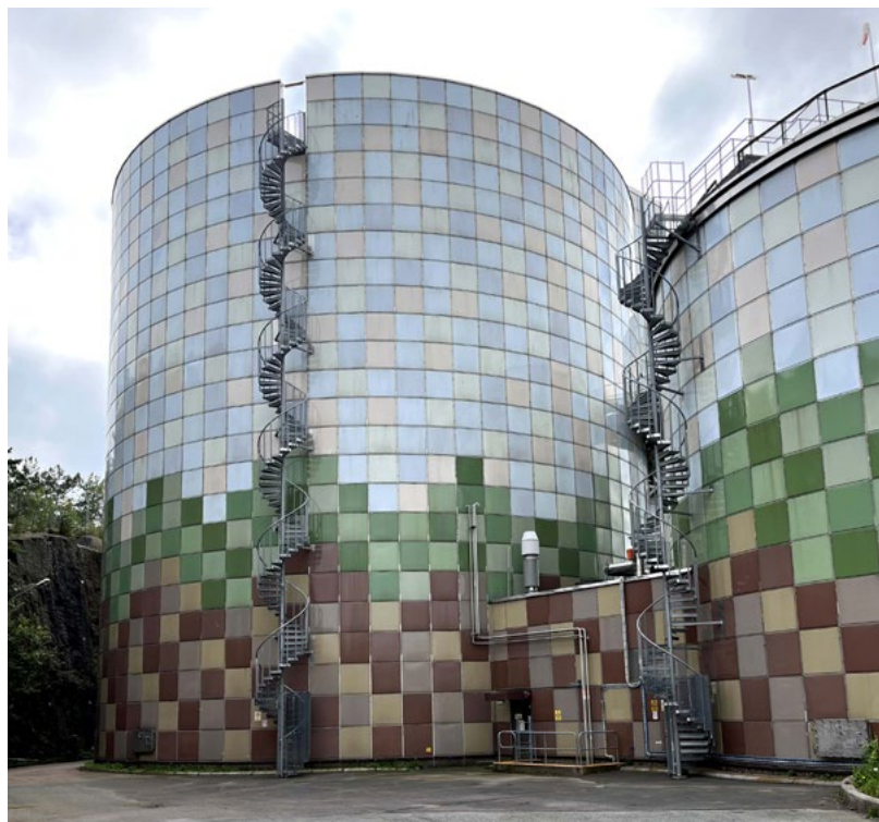
Råtnetank på Ryaverket i Göteborg.
