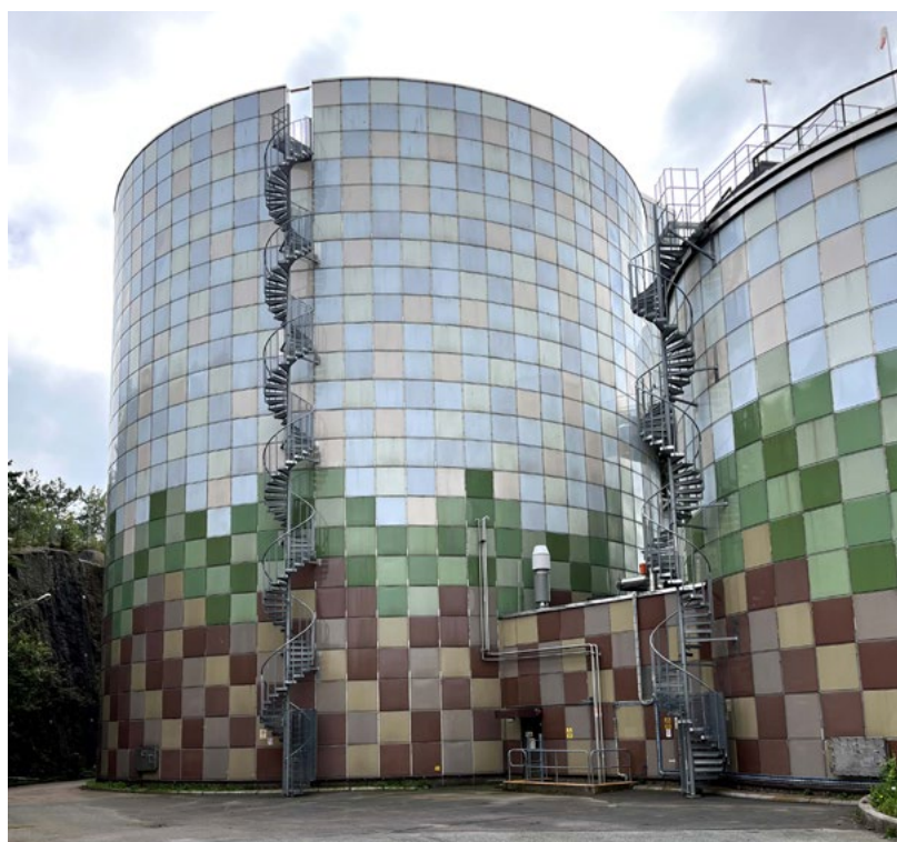
Råtnetank på Ryaverket i Göteborg.
