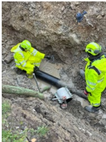
Figur 88. Utbedring av lekkasje på duk til støpejernsledning (Foto: GIVAS)
