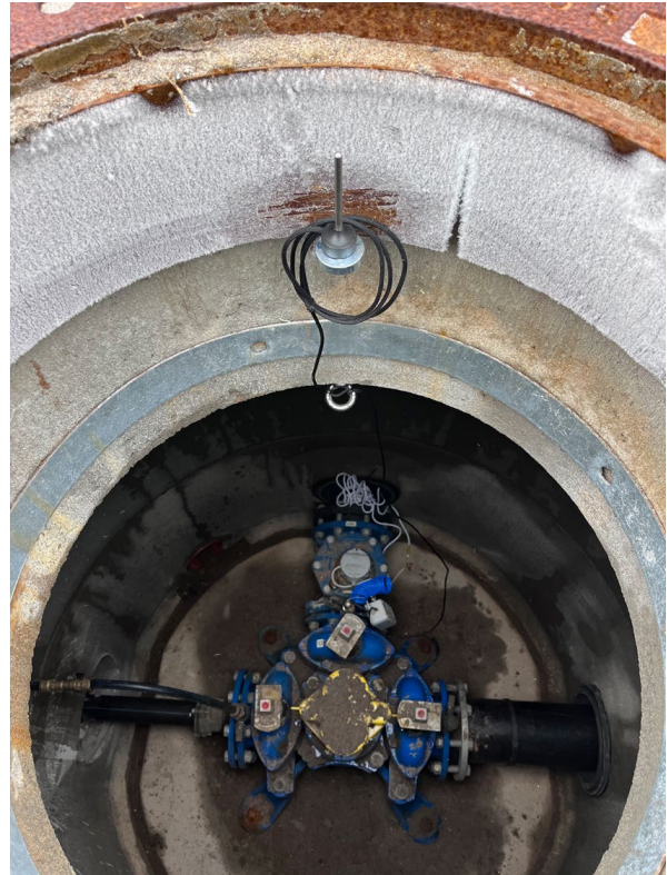
Figur 39. Data sendes via NB-IoT (Foto: Gutermann)
