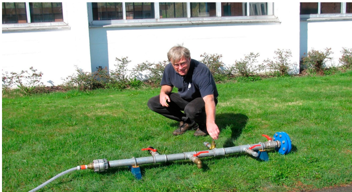
Figur 3. Arnt Olav Holm med test av fire typiske stikkledningslekkasjer i 2009 (Foto: Arnt Olav Holm)
