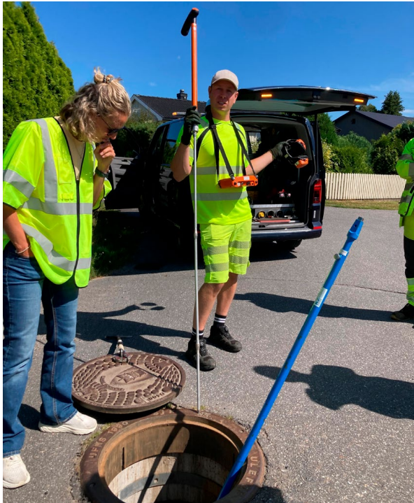
Figur 77. Herman Dingstad (Vestfold Vann) med lytteapparat og lyttestav. (Foto: Marie Sagen)
