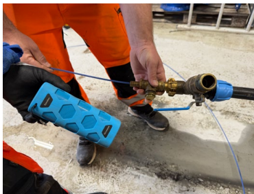
Figur 104. Innføring av PipeMic i PE stikkledning (Foto: Odd Petter Habbestad)
