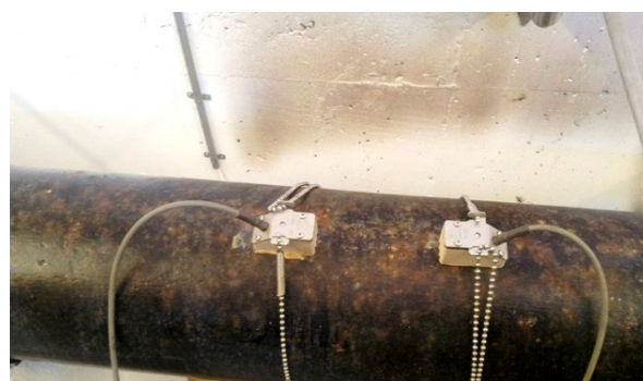
Figur 43. Clamp-on måler brukes til måling av vannføring utenpå røret for å påvise mulig lekkasje (Foto: Jan-Helge A. Høvset)
