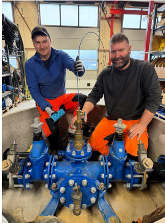
Figur 101. Tor Eivind Gilje og Ivar R. Turøy demonstrerer innføring av stakefjær med mikrofon i kum. Legg merke til 50 mm service-ventiler. (Foto: Odd Petter Habbestad)
