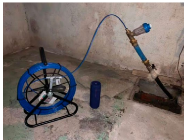
Figur 105. Innføring av PipeMic fra kjeller (Foto: Odd Petter Habbestad)
