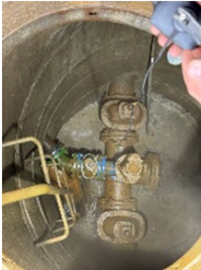
Figur 90. Montering av lydlogger i kum (Foto: GIVAS)
