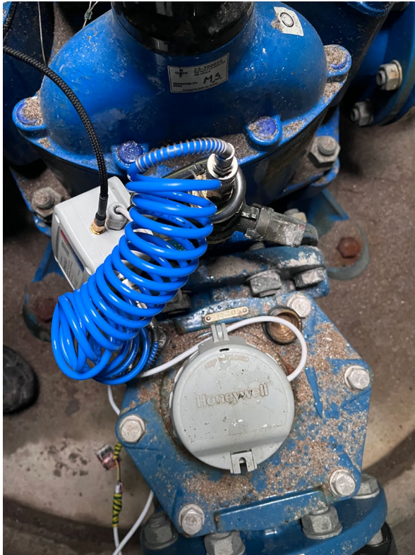
Figur 38. Montering av sensor som registrerer puls fra analog vannmåler (Foto: Gutermann)
