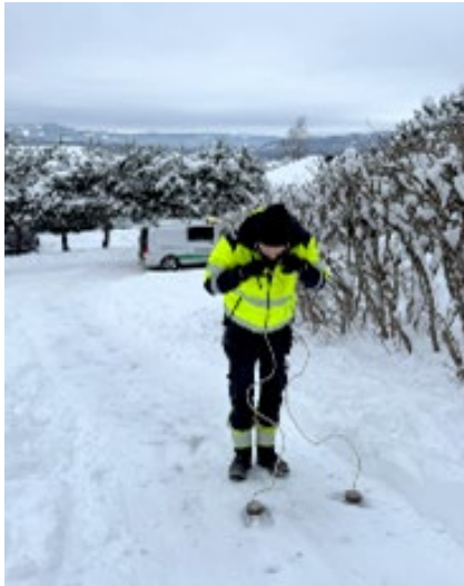
Figur 84. Haakon Magnus Halvorsrud lytter etter lekkasjelyd med marklytter (Foto: GIVAS)
