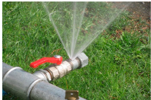
Figur 7. Tærehull på 1" galvanisert rør som utgjør lekkasje med en vannmengde på 0,15 liter per sekund (Foto: Arnt Olav Holm)
