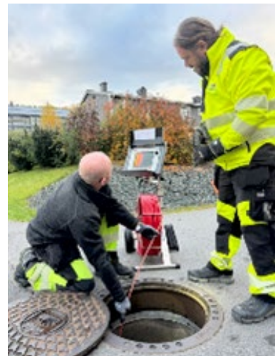
Figur 89. Tommy Storberget og Audun Nordseth rørinspiserer avløpsledning på jakt etter innlekk/utlekk (Foto: GIVAS)
