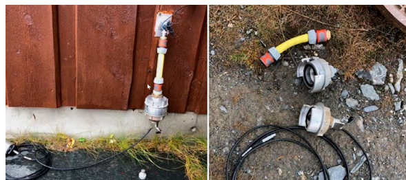
Figur 46. Tilkobling av hydrofoner via utekran (Foto: Sigurd A. Flatmo, Vestre Slidre kommune)
