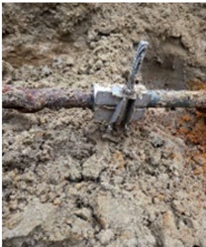
Figur 87. Galvanisert stålledning reparert med reparasjonsklammer (Foto: GIVAS)
