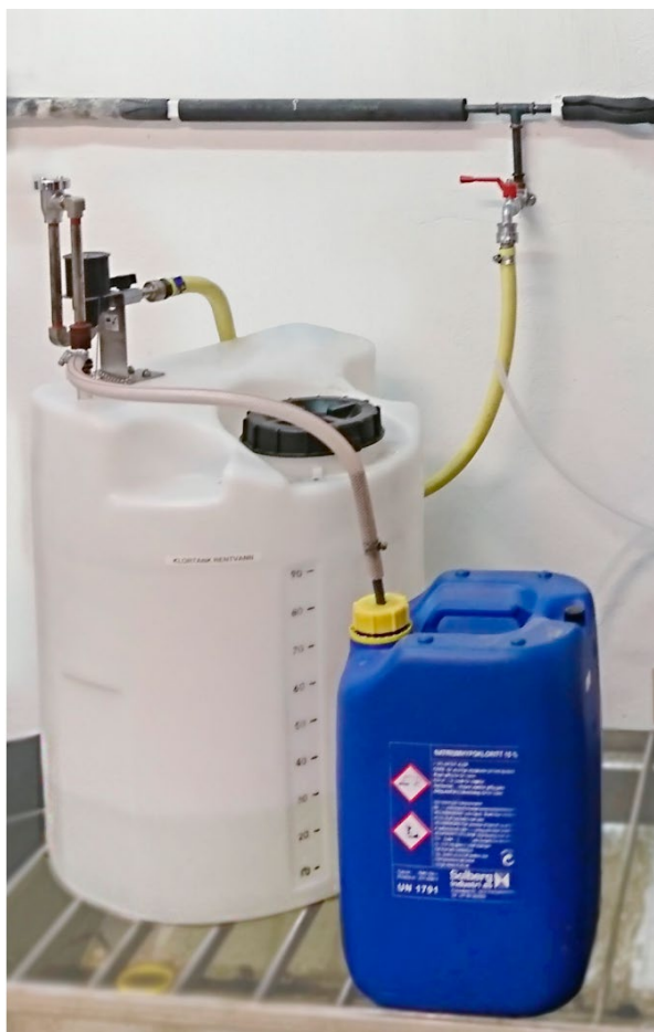
Figur 22: Ejetorsystem for automatisk fortynning av kjemikalier i mindre kvanta. Foto: Alfsen og Gundersen AS.
