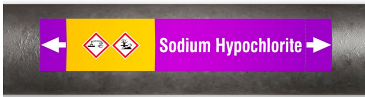
Figur 77: Eksempel på merking av rør i henhold til NS-ISO 20560. (For ordens skyld: merkingen skal være på norsk.) Bilde: Brady Corporation, www.brady.no .
