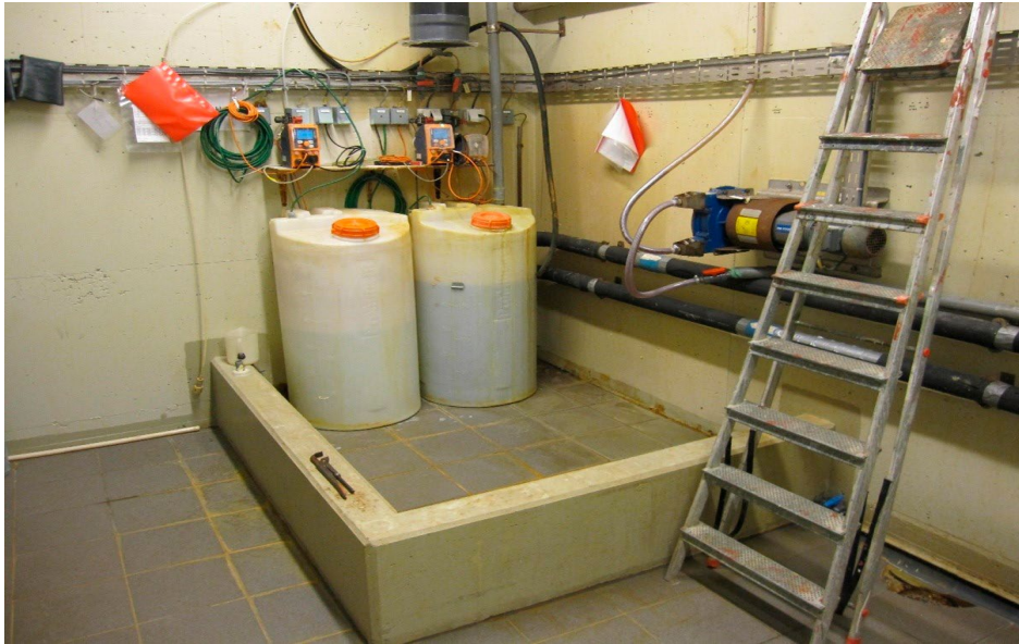
Figur 69: Eksempel på dårlig sikkerhet mot blanding: de to tankene inneholder hhv. klor (natriumhypokloritt) og jernklorid.
