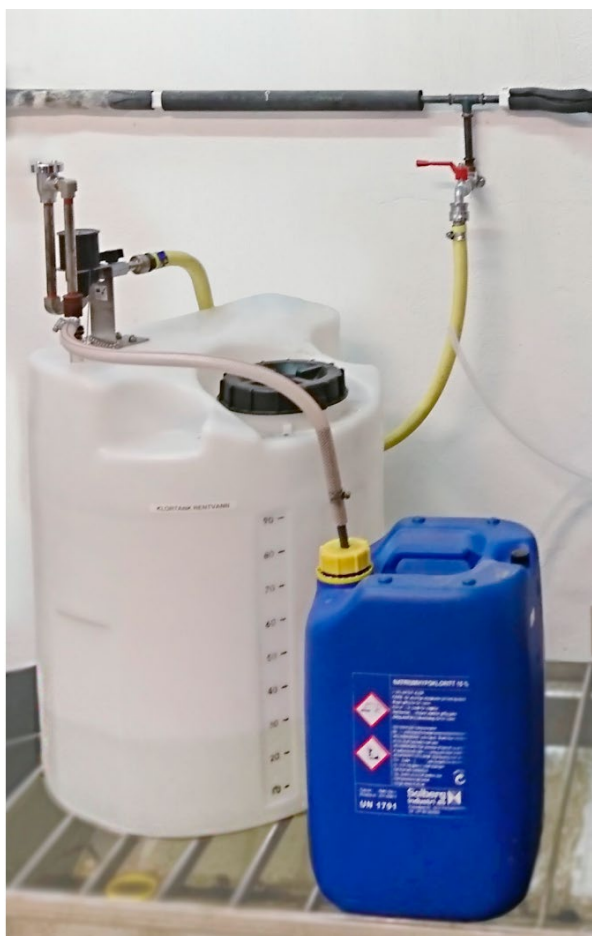
Figur 10: Ejektorsystem for automatisk fortynning av kjemikalier i mindre kvanta. Foto: Alfsen og Gundersen AS.
