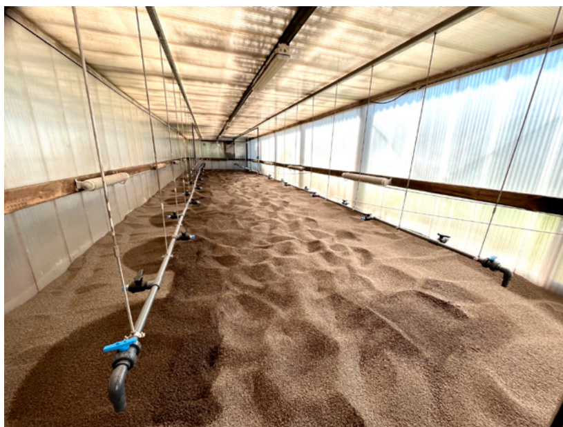
Figur 2: Spredesystem med dyser i forfilterhus (biofilter)
