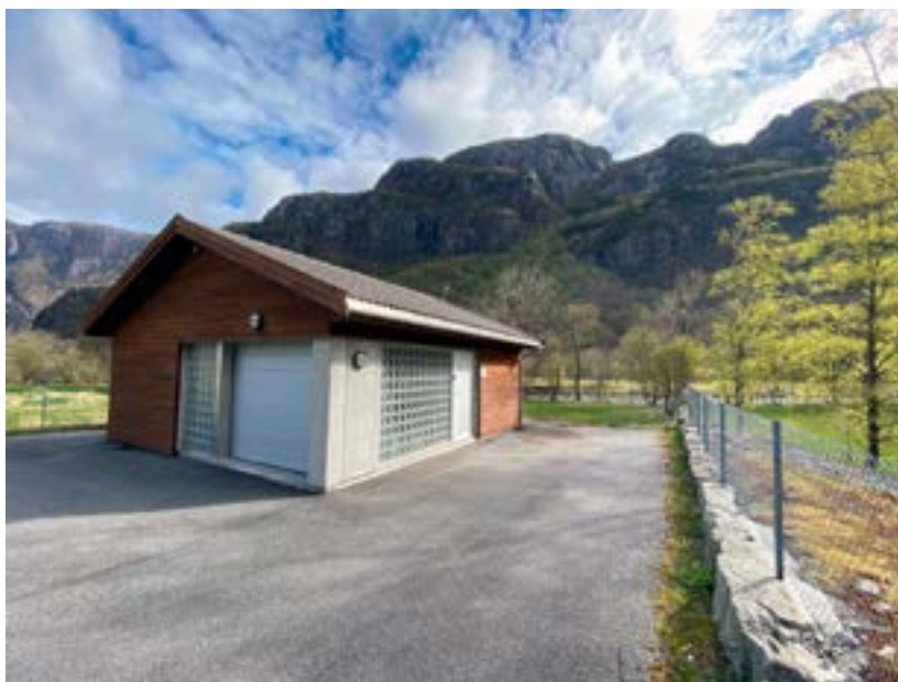
Dirdal vannbehandlingsanlegg i Gjesdal kommune vant semifinalen i Rogaland i grunnvannsklassen
