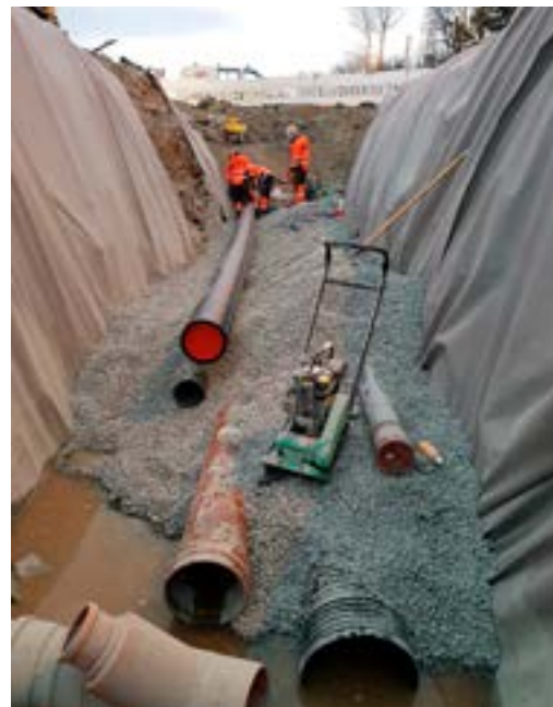
Det brukes store mengder pukk i en rørgroft. Det bør vurderes om pukken kan erstattes med stedlige masser. Foto: Einar Sørensen Maskinentreprenør AS
