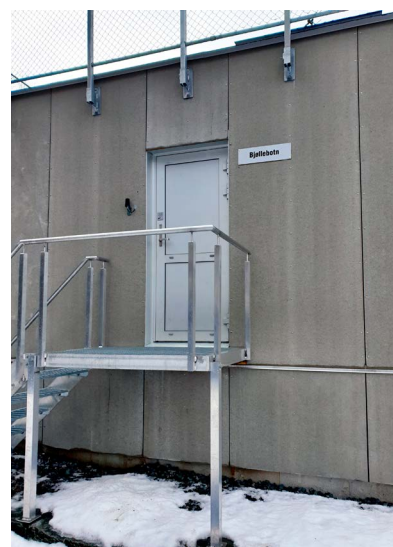
Høydebassenget etter rehabilitering - utvendig.
