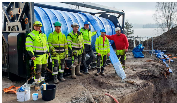
650 meter Primus Line DN 500 klar for installasjon.
