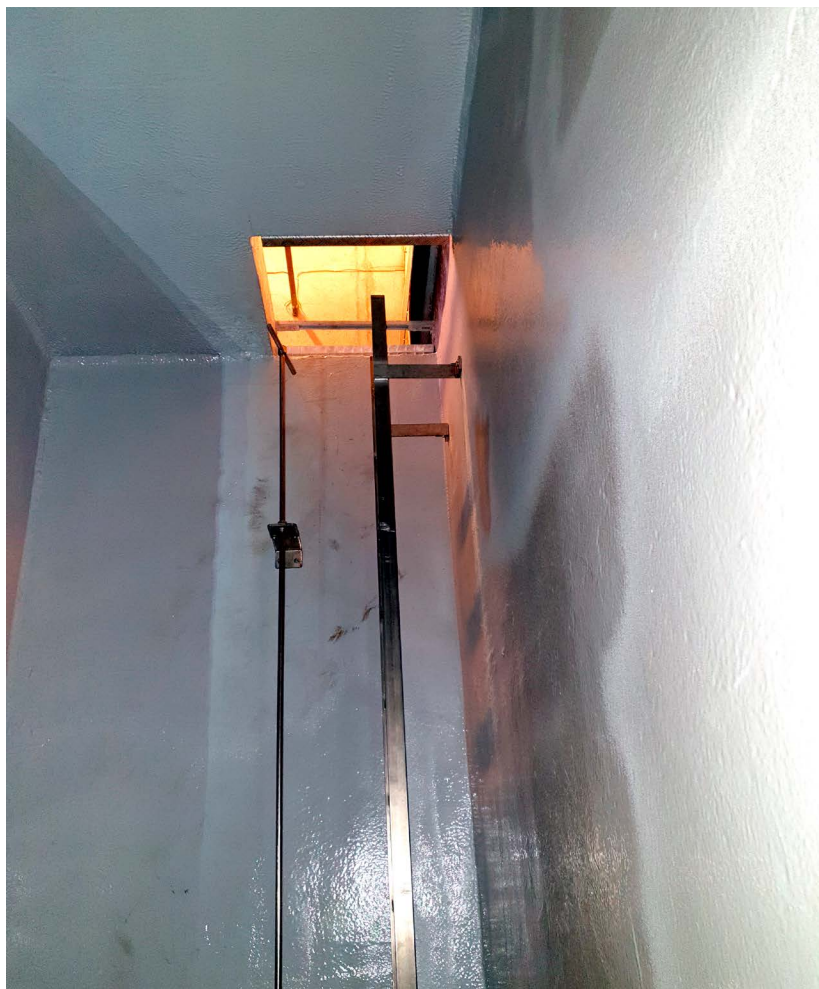
Høydebassenget etter rehabilitering - innvendig.
