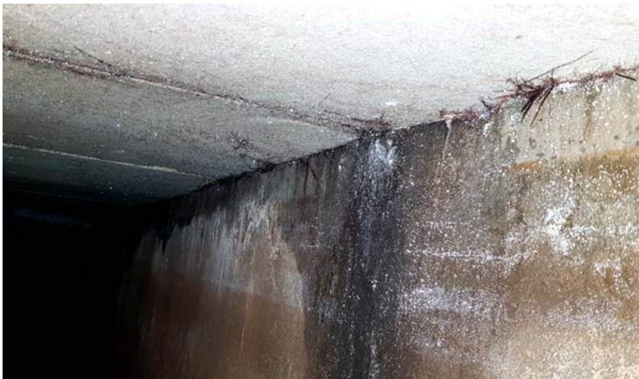
Høydebassenget før rehabilitering - innvendig.
