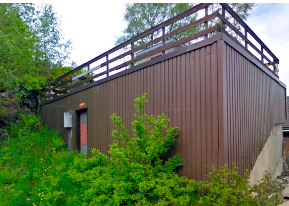
Høydebassenget før rehabilitering - utvendig.
