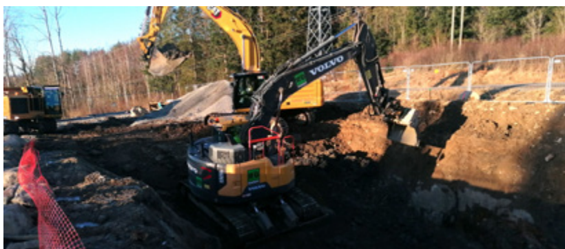
Gravearbeidene er i gang på Vannsenteret på Ås.
