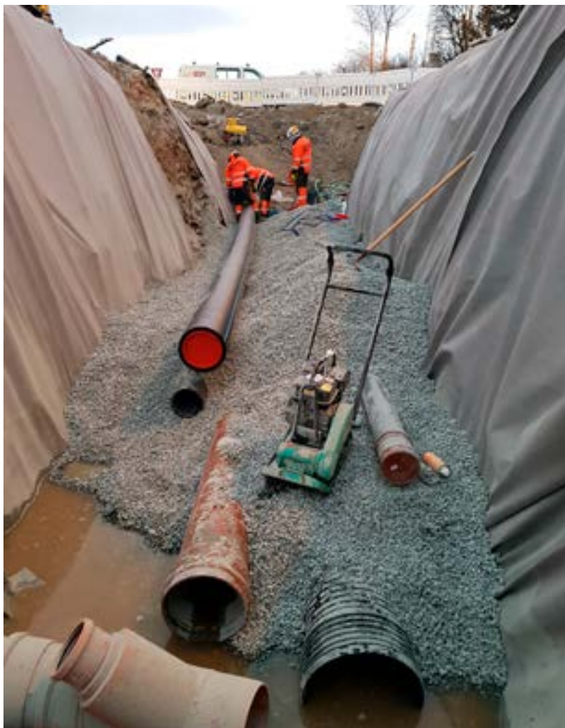
Det brukes store mengder pukk i en rørgroft. Det bør vurderes om pukken kan erstattes med stedlige masser.
