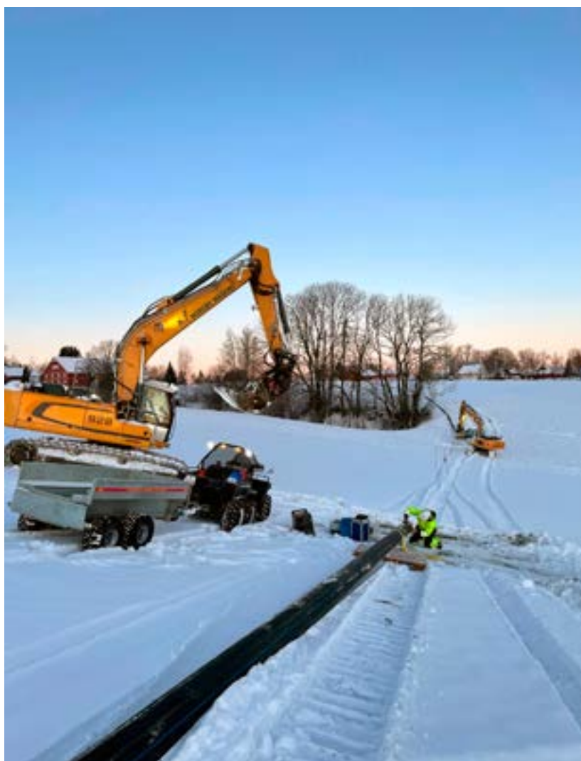
Legging av provisorisk vannledning i forbindelse med leirskredet i Gjerdrum. Foto: Christian Mjølvi, NRV.
