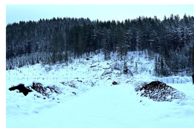
Rankekompostering ved Fossan laguneanlegg
