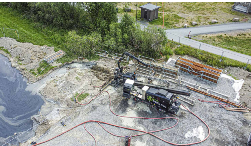
STYRT BORING: Boreriggen er elektrisk drevet, og kan bore helelektrisk der strømmettet har kapasitet til det. Foto: Jørn Søderholm, Praktisk Talt AS
