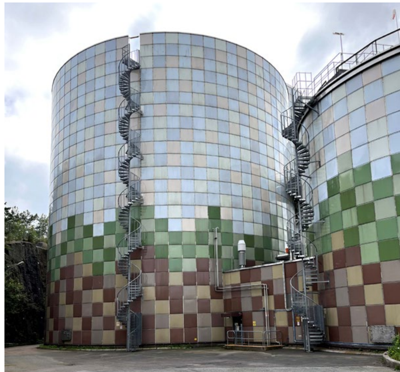
Råtnetank på Ryaverket i Göteborg.
