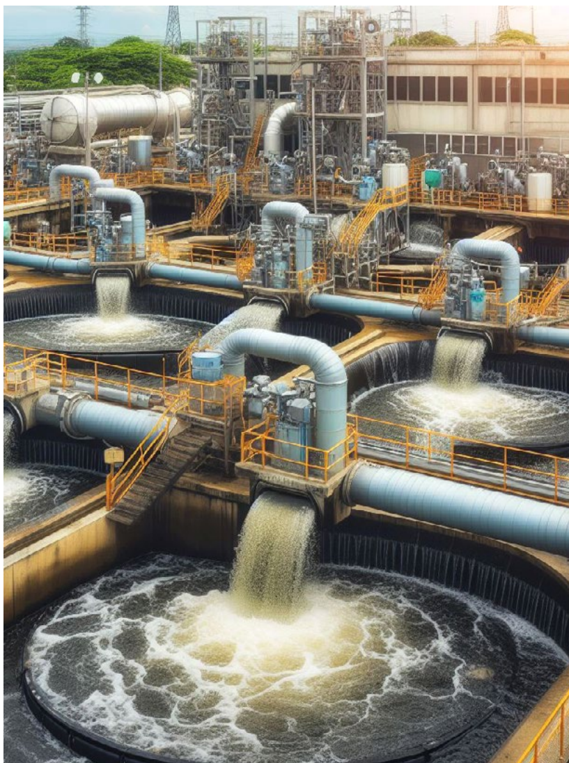
Et avløpsreanseanlegg som er overbelastet og under oppgradering på grunn av fremmedvann (bilde generert av Microsoft Copilot, 2024).
