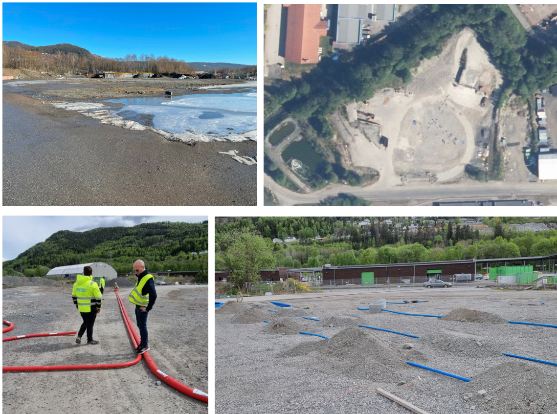
Figur 5: Venstre bilde øverst viser riggområde før tilrigging (Foto: Drammen kommune). Høyre bilde øverst viser riggområde sett fra luften mens området var rigget for forsøkene (Statens kartverk, 2023). De nederste bildene viser tilrigging på anlegget (Foto: Multiconsult & Drammen kommune)
