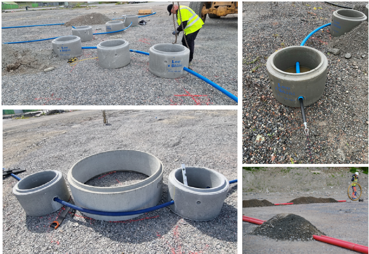
Figur 13: Bilder som viser bygging av vinkler. Bildene til venstre viser hvordan PE-røret ble fiksert i riktig vinkel med bruk av kumringer og ved hjelp av hjullaster og kjettingskrev (Foto: Multiconsult). Bildet øverst til høyre viser at enden på ledningen akkurat har kommet ut gjennom bendet og bildet nederst til venstre viser hvordan PP varerørene ble satt sammen 3x30 graders bend og 1x90 graders bend samt rettstrekninger og fiksert med pukk. Langbend med radius 600 mm (Foto: drammen kommune).
