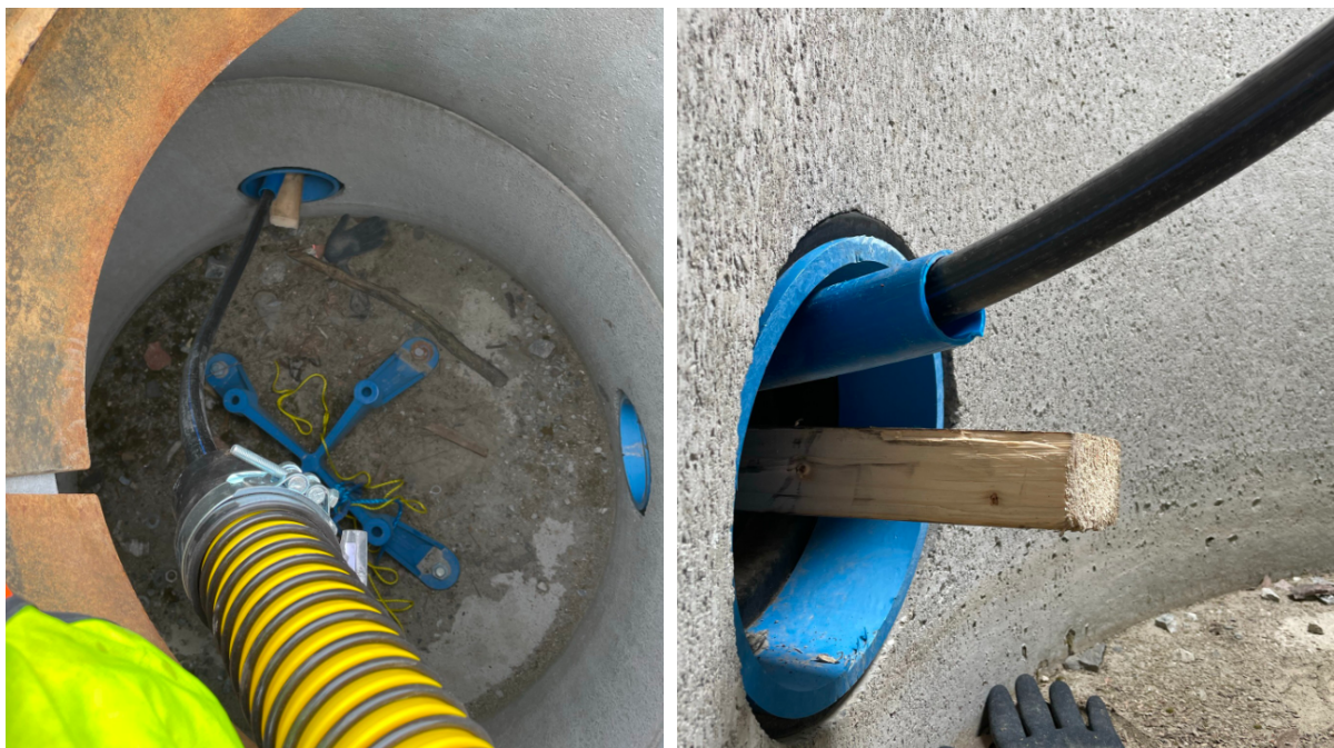
Figur 18: Bildet til venstre viser hvordan medierøret er ført opp igjennom tigersvansen/slangespareren og ut gjennom kummen i varerør. Bildet til høyre viser hvordan varerør og medierør er festet inne i kummen før røret føres på utsiden (Foto: Drammen kommune).
