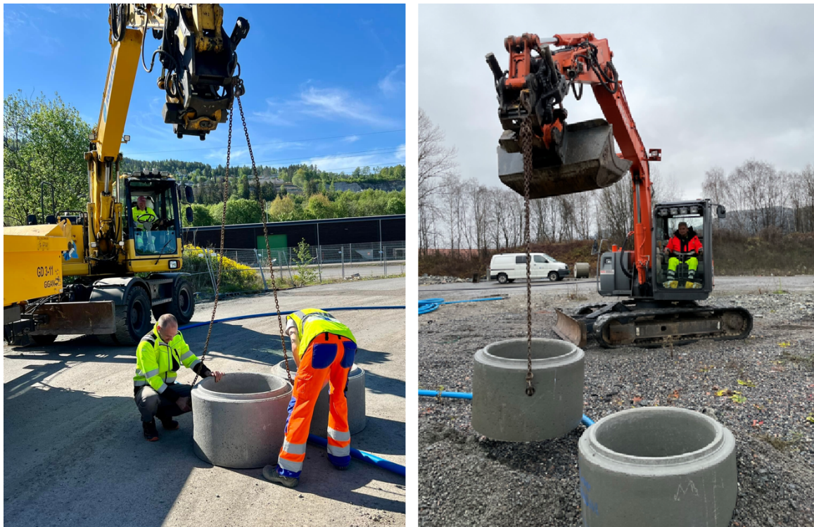
Figur 10: Bilder tatt i felt under forsøkene. Gravemaskin ble benyttet for å rigge til testene (foto Drammen kommune).
