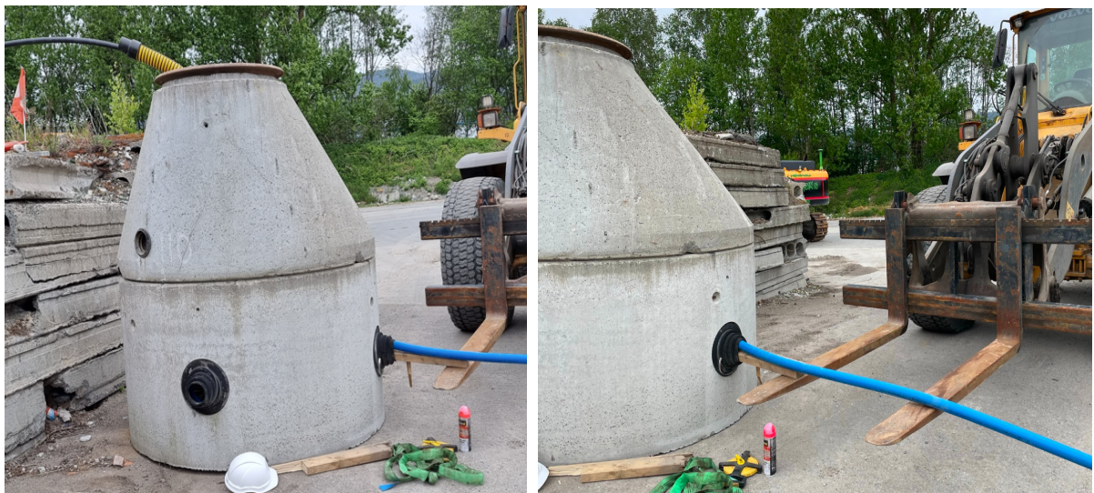
Figur 17: Bilder av forsøk med uttrekking gjennom kum. Bildene viser hvordan forsøket og kummen er konstruert for å gjenskape et realistisk tilfelle (Foto: Drammen kommune og Multiconsult).
