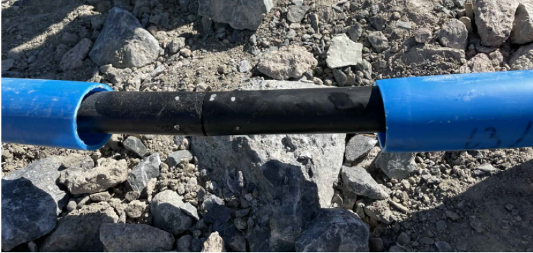
Figur 20: Spjelkeskjøting av medierør.
