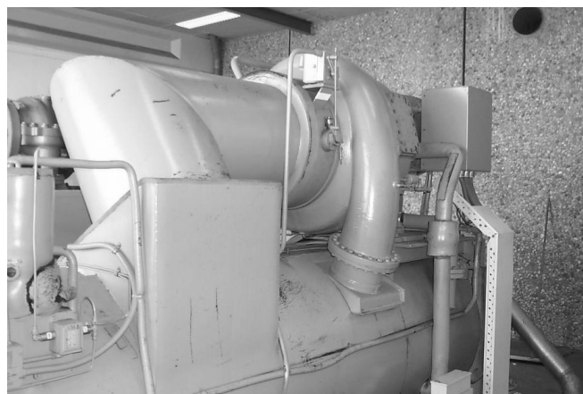
Figur 9. Varmepumpe på HIAS fra 1982. (Foto: HIAS)
