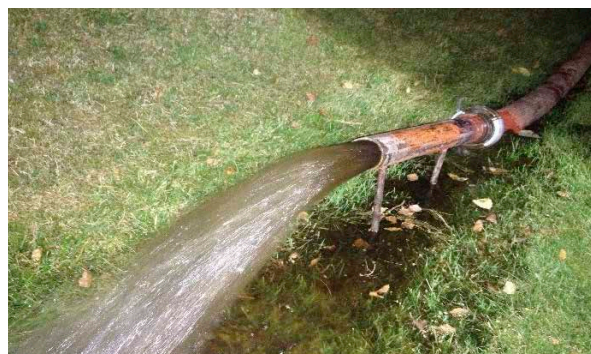
Figur 11: Fullskala tappeprøver fører vanligvis til spyleffekt i ledningsnettet og forringet vannkvalitet.
