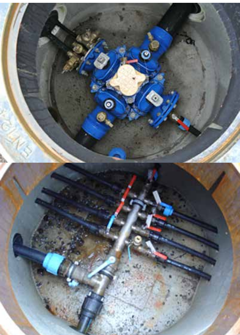
Figur 10.7: Eksempel på kobling i kum i Bømlo kommune.
