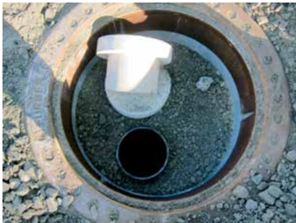
Figur 5.7: Ferdig kum for stake-/spylepunkt og stoppekran. Foto: Sigbjørn Kloster, Stavanger kommune
