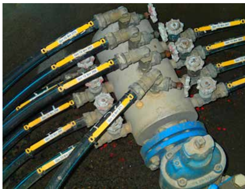
Figur 10.4: Stikkledningskum i Haram kommune. Laminerte etiketter med gnr/bnr er stripset til hver ledning. Foto: Nils Kristen Skaar, Haram kommune.
