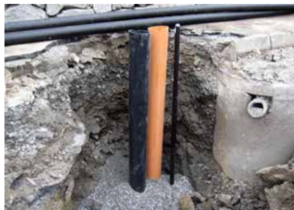
Figur 5.6: Etablering av kum for stake-/spylepunkt og stoppekran. Foto: Sigbjørn Kloster, Stavanger kommune
