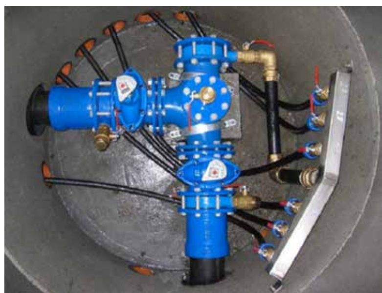
Figur 10.2: Stikkledningskum i Voss
