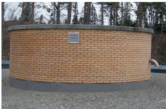
Figur 6.21. Takbygg over nedstigingsluker. Vikåsen høydebasseng. Trondheim kommune. Innvendig trapp fra ventilkammer opp i takbygg. Luker kunne med fordel vært montert med sarg for å unngå spyling ned i vannkammer ved renhold. Ventilering er uten filtrering av luft, samt at det er mulig å føre inn en slange i ventilasjonsrøret.
