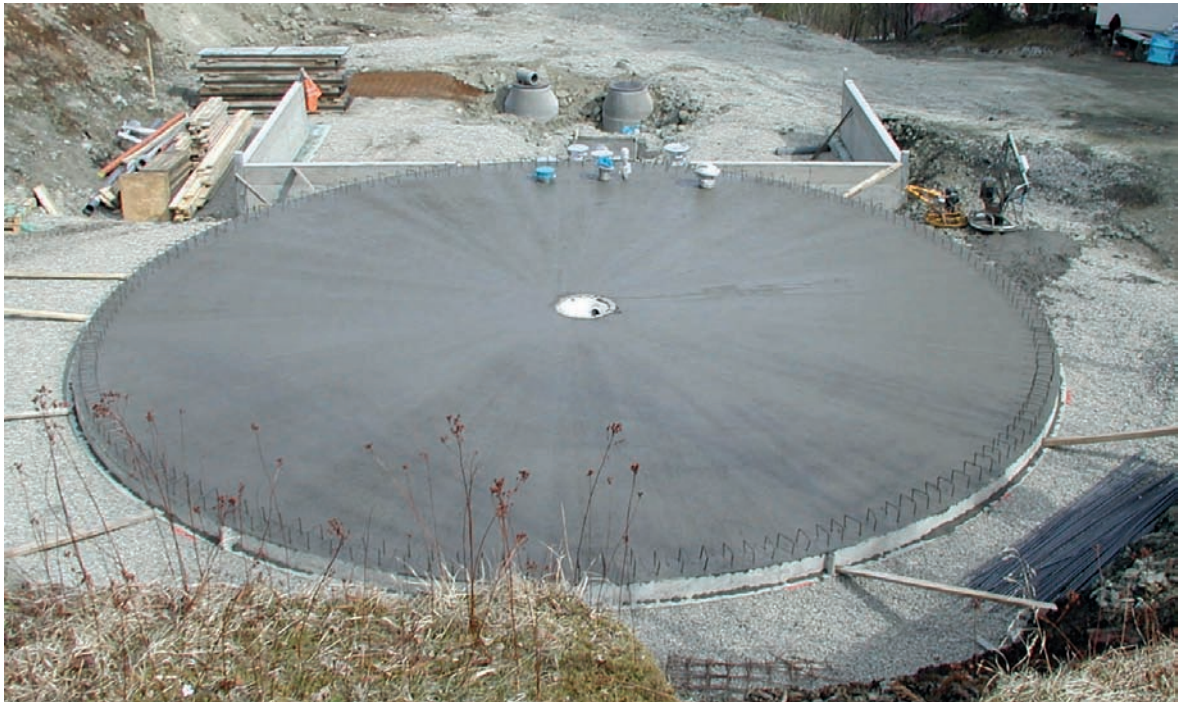
Figur 6.9: Støpt bunnplate for montering av glassfiberelementvegger.
