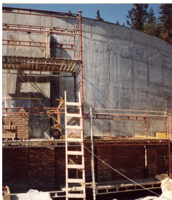
Figur 6.12: Vegg under utførelse. Vegg støpt i etterspent betong. Isolert med mineralull. Forblendet med teglsteinsmur.
