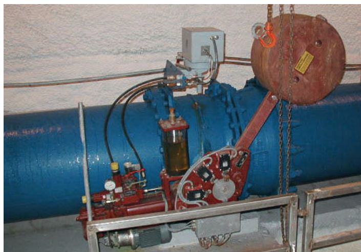
Figur 7.3: Rørbruddsventil (falloddsventil)
