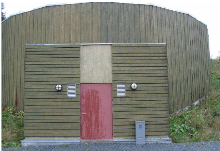
Figur 6.14: Hyllberget høydebasseng. Stjørdal kommune. Vannvolum 1800 \text{ m}^3 . Utvendig isolert med trepanel
