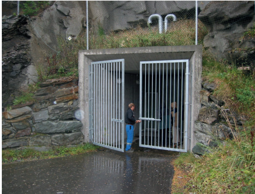
Figur 6.30: Portal Bjørnmyra basseng. Gitterport ble montert i ettertid for unngå hærverk, spraymaling i portal.
