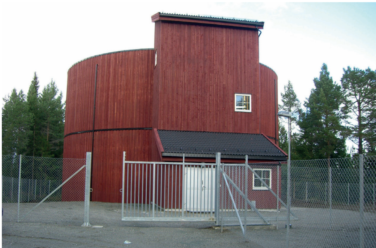
Figur 13.7.1 Klæbu kommune. Lauvåsen høydebasseng. 2006. Volum 2500 m 3 . Plasstøpt betong kledd med panel.
