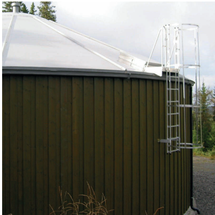
Figur 6.19. Luke på skrått tak i glassfiberelementer.
