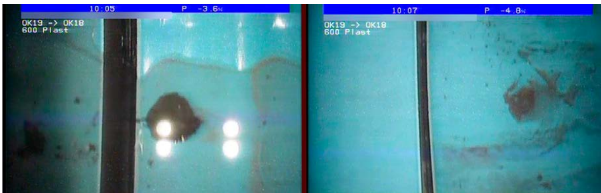
Figur 8-6: Disse bildene viser samme skjøt, fotografert fra to ulike vinkler ved kamerainspeksjon. Avvinklingen er betydelig høyere enn produsentens krav. Flere kommuner stiller i tillegg strengere krav enn produsenten, noe som gjør denne løsningen uakseptabel.
