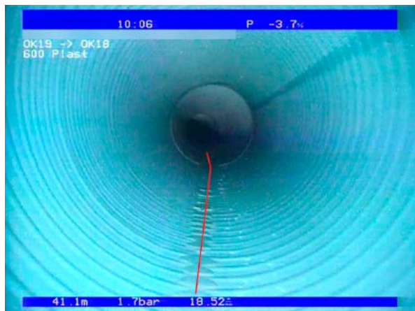
Figur 8-16: Vinkelendringen er større enn toleransekrav.
