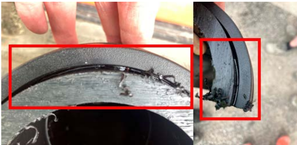
Figur 7-15: Det blanke området mellom rørene (markert med rød firkant) er varmetråder. I henhold til NS 416 skal det ikke være synlig sveisetråd etter utført sveising.
