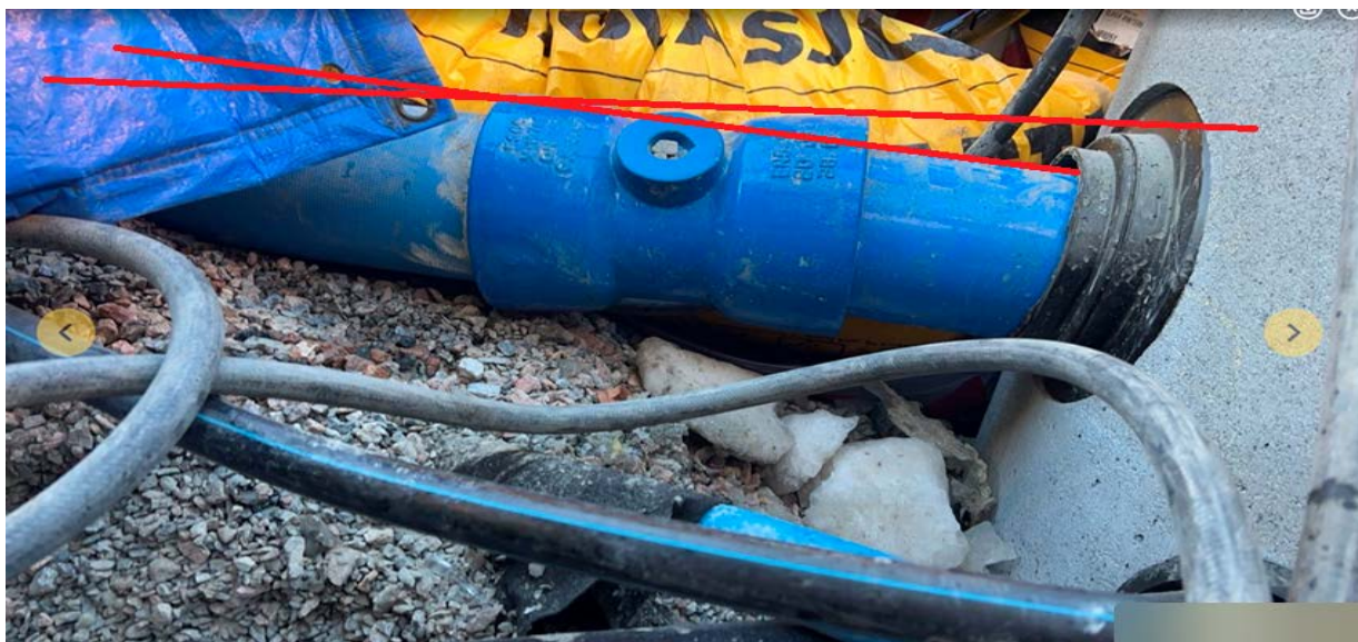
Figur 7-3: Vinkelendring i dobbeltmuffe er utenfor produsentens toleransekrav. I tillegg er det ikke god nok fundament inntil kum.
