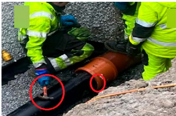
Figur 8-14: Løpemuffe slås på plass med hammer.
