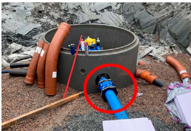
Figur 7-7: Muffen (rød sirkel) som er brukt her (rød sirkel) er ikke iht. tegning eller beskrivelse.
