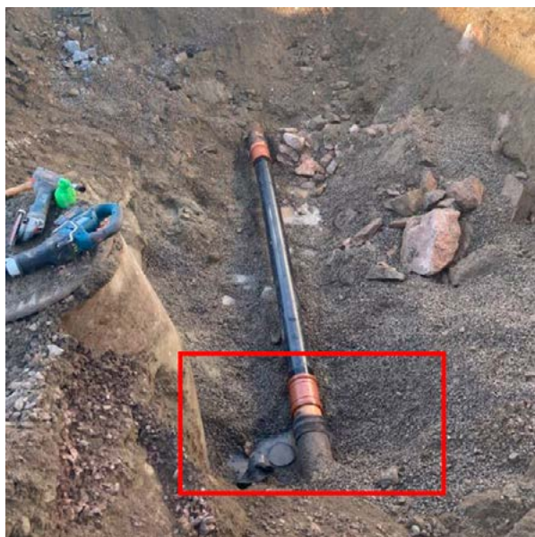
Figur 8-15: PVC-overgang mot betong spiss er feil utført og ikke montert i henhold til leverandørens anvisning. Overgangen er nesten svart (rød firkant), men skal være lys brun. Plasten er blitt skadet.
