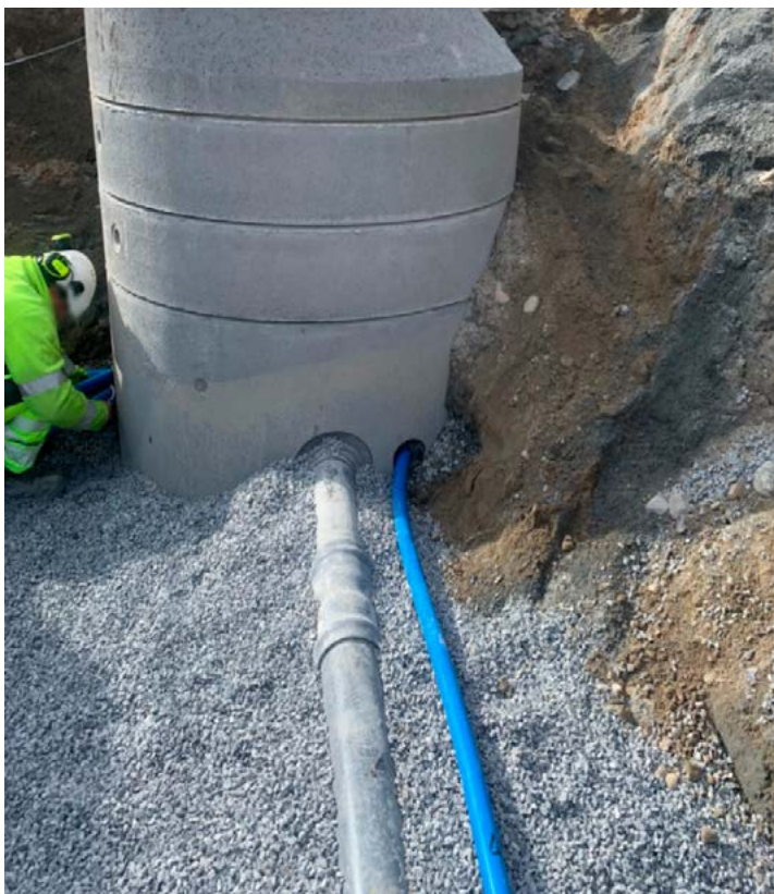
Figur 8-1: Fiberduk er ikke etablert der fiberduk er påkrevd
