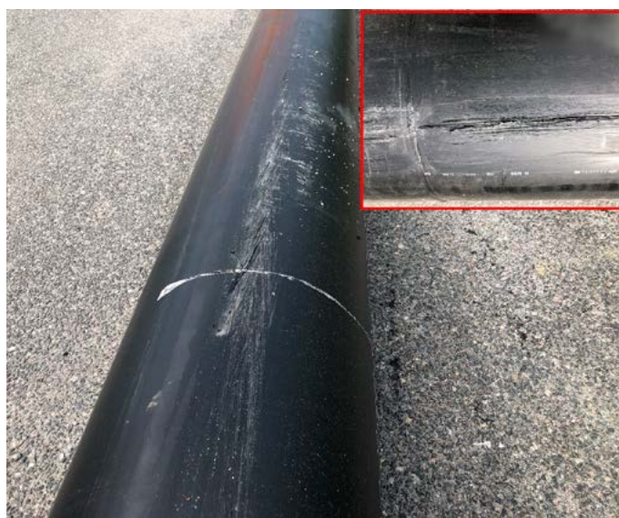
Figur 7-8: Oppskrapet plastrør med flere langs- gående riper og slitasjemerker. Skadene har oppstått som følge av at det har blitt dratt langs asfalten.
