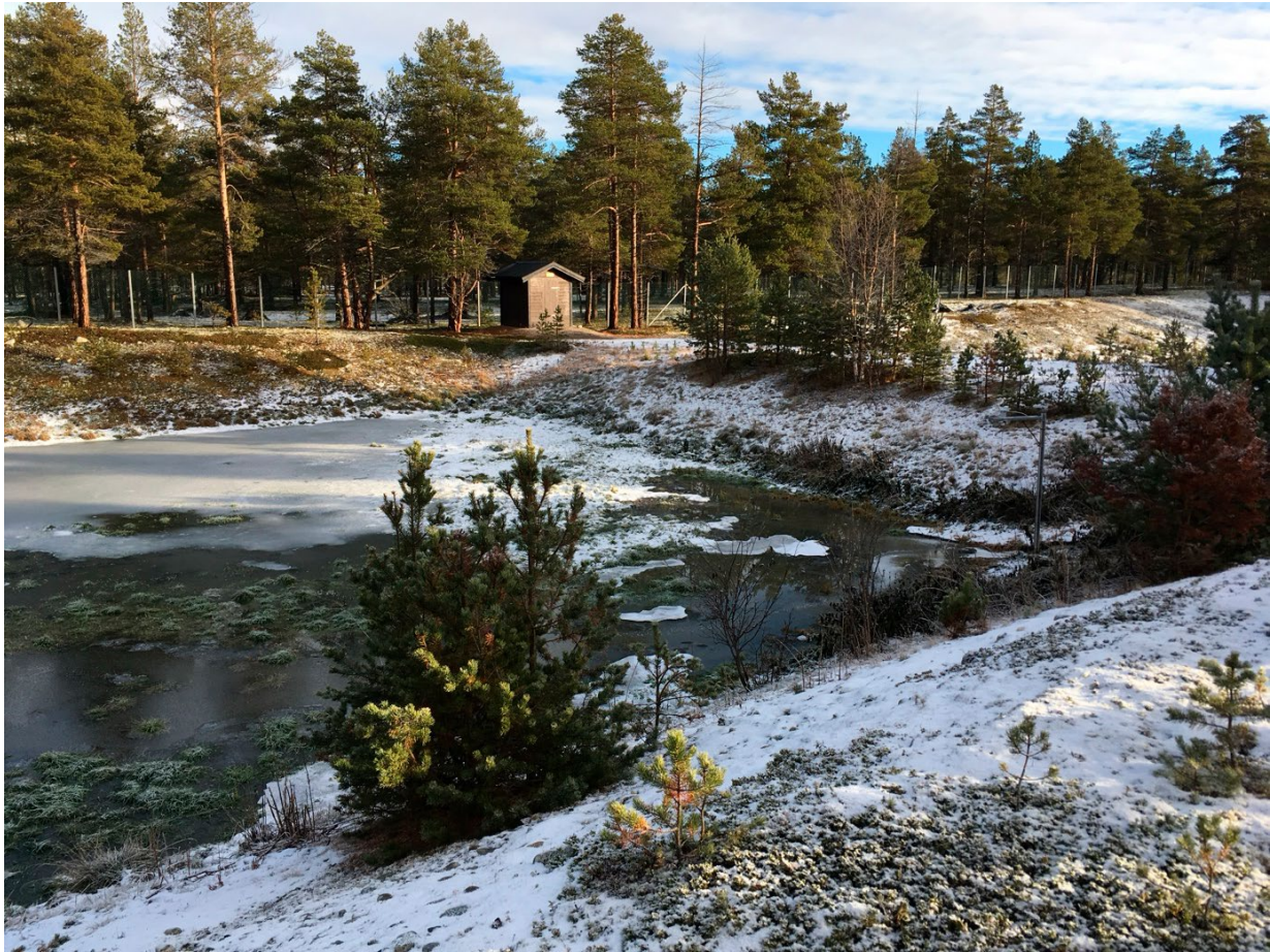
Figur 1: Lesja infiltrasjonsanlegg for 3000 pe på Hosetmoen. Åpent infiltrasjonsbasseng B4, med overbygd prøvetakingsbrønn i bakgrunnen. Foto: Asplan Viak v/Knut R Robertsen, 2016.
