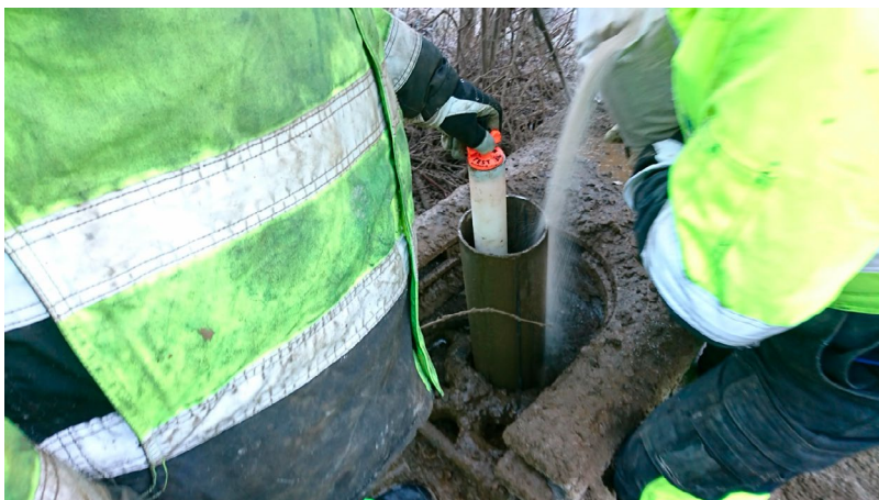
Figur 8: Boring med Odex-rigg for etablering av prøvetakingsbrønn. Odex-140 med 168 mm foringsrør. Foto: Asplan Viak v/Rolf E. Forbord.
