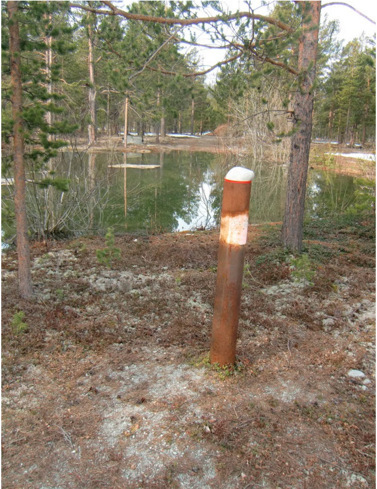
Figur 5: Prøvetakingsbrønn uten overbygg, ved Bjorli infiltrasjonsanlegg for 3000 pe, Lesja kommune. Foto: Asplan Viak v/Knut Robert Robertsen.
