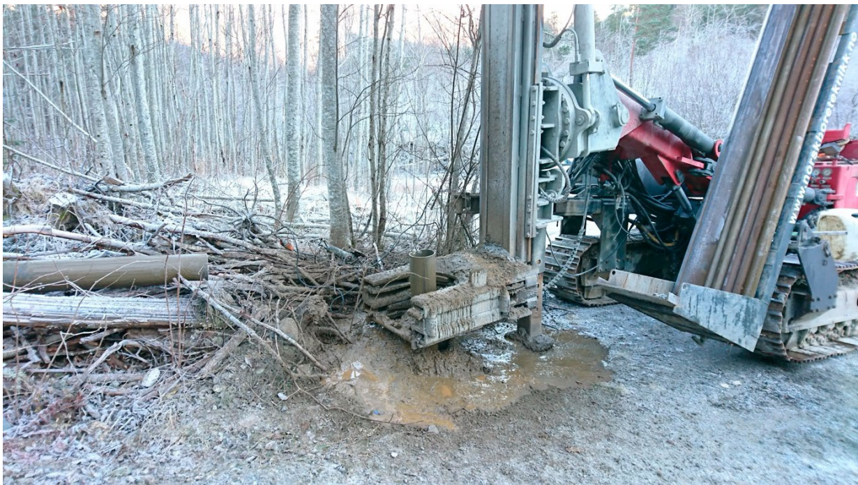
Figur 8: Boring med Odex-rigg for etablering av prøvetakingsbrønn. Odex-140 med 168 mm foringsrør. Foto: Asplan Viak v/Rolf E. Forbord.
