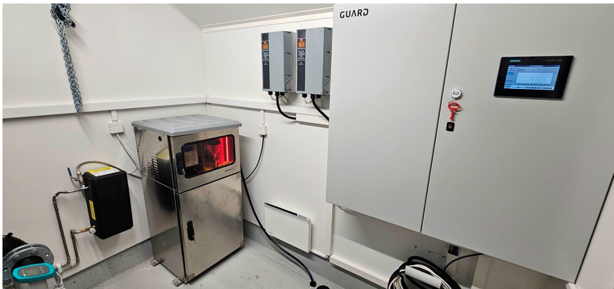
Figur 15: Mengdeproporsjonal døgnblandprøvetaker for prøvetaking av infiltrert og rensset avløpsvann. Ådalen RA ved Blefjell. Foto: Bleva ved Dag Åsmund Bilstad, 2025.
