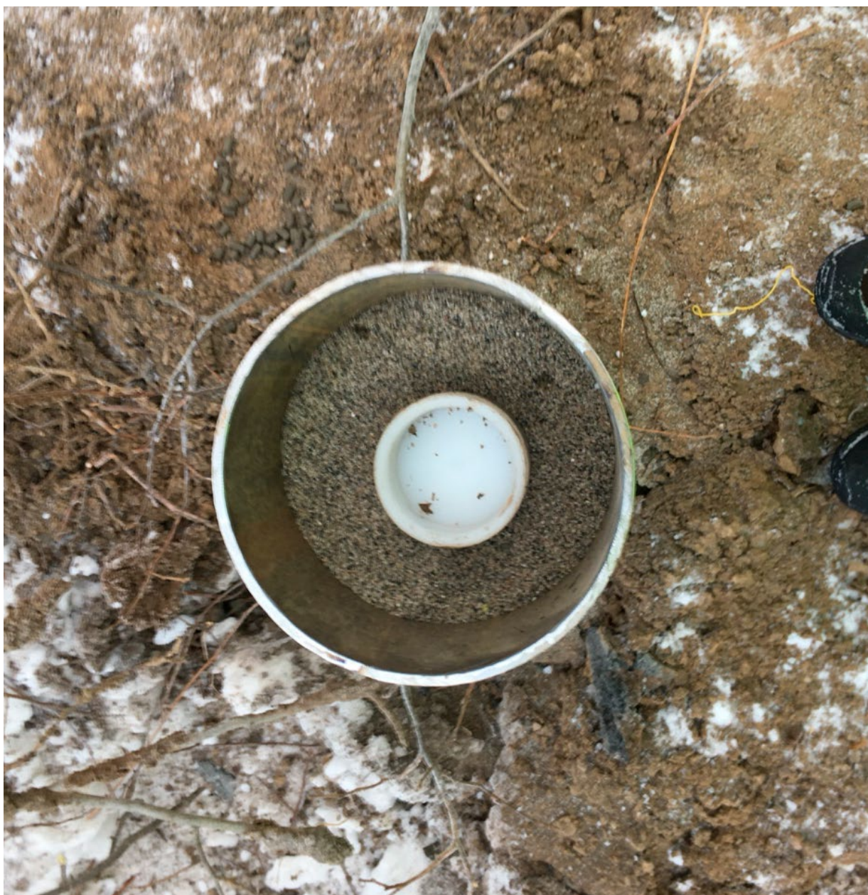
Figur 11: Gruskasting av prøvetakingsbrønn, til topp foringsrør. Foringsrøret trekkes opp under montering av prøvetakingsbrønn, og blir stående igjen til ca. 1 m over terreng og 2-3 m under terreng. Foto: Asplan Viak v/Rolf Egil Martinussen.
