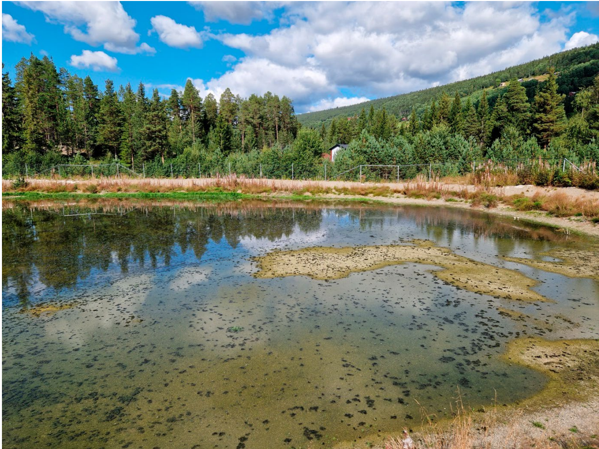
Figur 19: Øvre Uvdal renseanlegg for 3000 pe. Åpent sandfilterbasseng benyttes som biologisk rensetrinn, etter mekanisk kjemisk forbehandling av avløpsvannet. Foto: Asplan Viak ved Knut Robert Robertsen.
