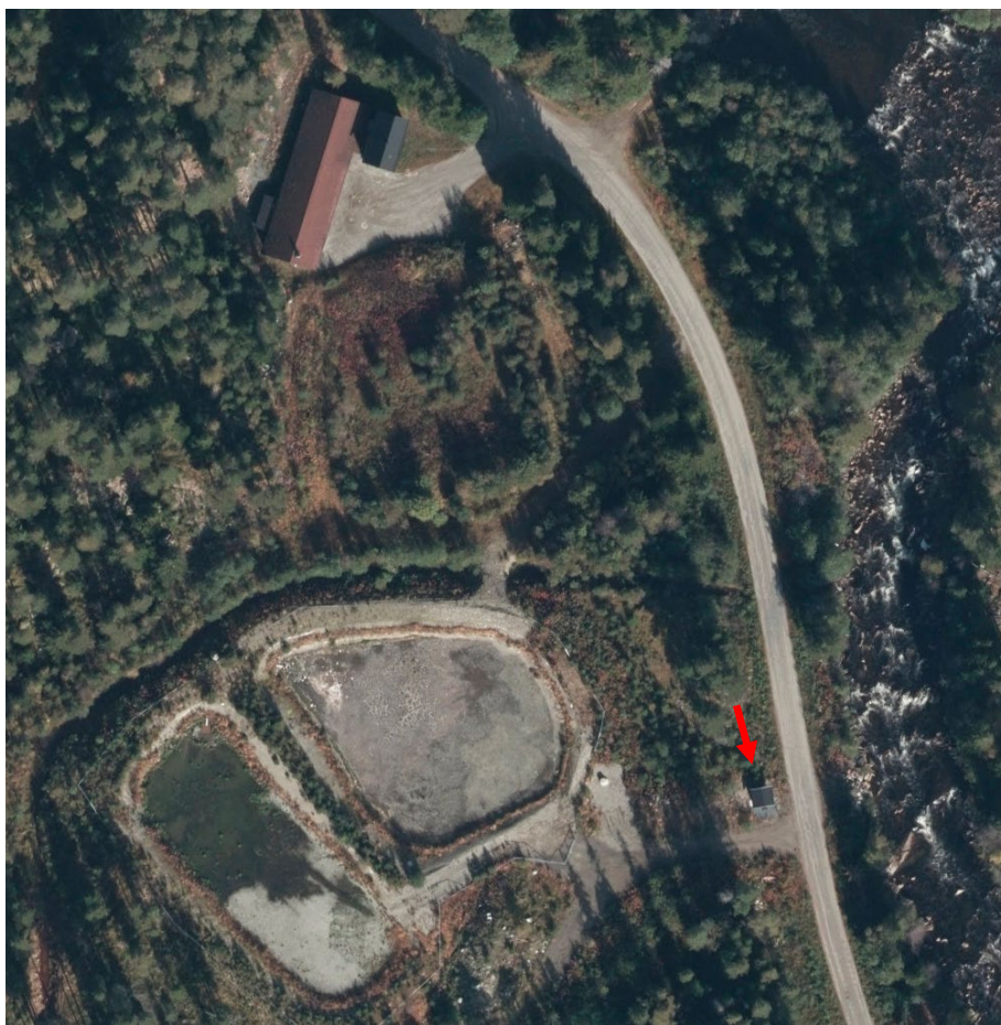
Figur 18: Øvre Uvdal RA i Nore og Uvdal kommune. Mekanisk kjemisk renseanlegg med biologisk rensetrinn i 2 åpne sandfilterbassenger. Infiltrert avløpsvann samles opp i drenerledninger, og ledes til prøvetakingsstasjon (vist med rød pil) før utløp til elva. Flyfoto.
