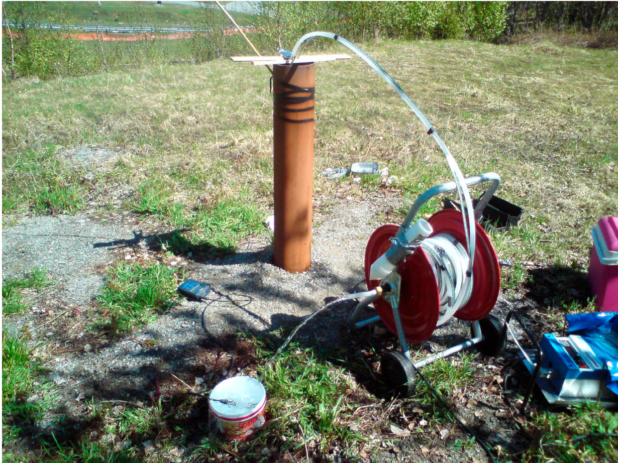
Figur 17: Renpumping av prøvetakingsbrønn etter brønnetablering. Bruk av aggregat, konverter, slangetrommel og konduktivitetsmåler. Foto: Asplan Viak v/Rolf E. Forbord.
