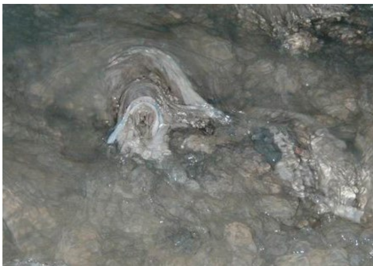
Figur 3: Bilde til venstre viser typisk synlig toalettsøppel når årsaken er feilkoblinger. Bilde til høyre er også en feilkobling, men her er det ikke synlig toalettsøppel fordi det er en slamavskiller som er koblet på overvannsnettets. Det er likevel en tydelig biofilm i påkoblingen.
