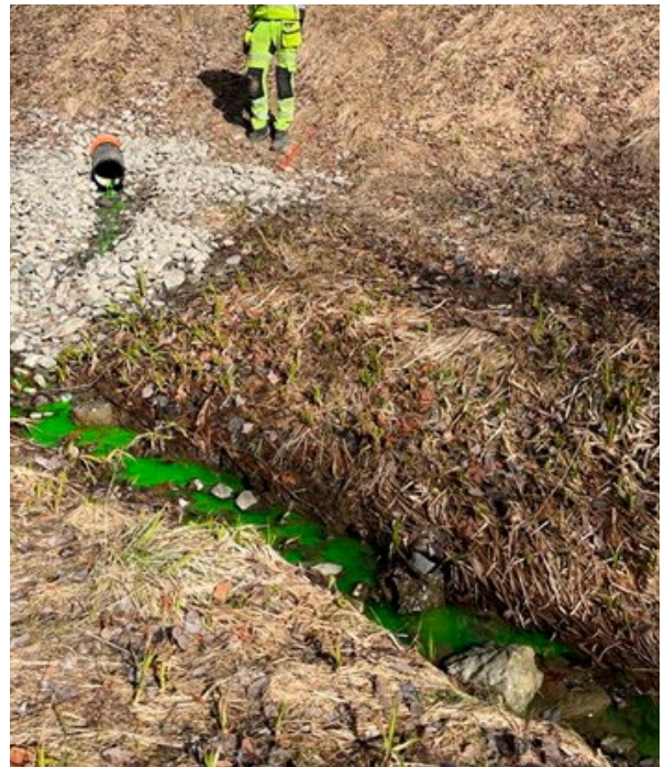
Farget spillvann som rennet ut av et overvannsrør.
