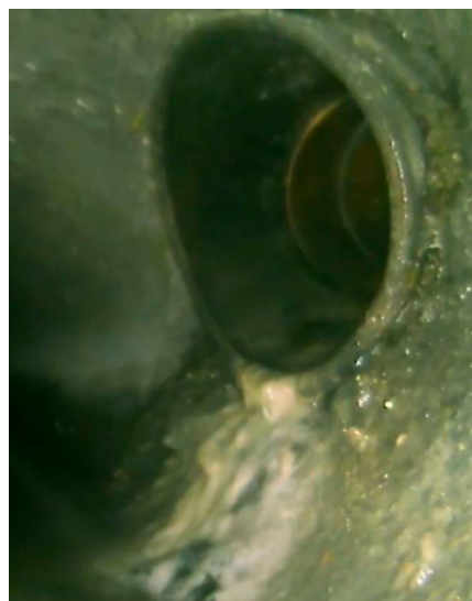
Figur 3: Bilde til venstre viser typisk synlig toalettsøppel når årsaken er feilkoblinger. Bilde til høyre er også en feilkobling, men her er det ikke synlig toalettsøppel fordi det er en slamavskiller som er koblet på overvannsnettets. Det er likevel en tydelig biofilm i påkoblingen.
