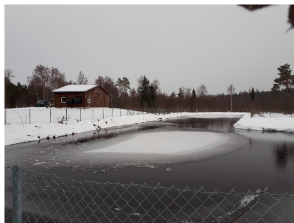
Figur 2-7. Bassenginfiltrasjon ved Dorøya vannverk i Orkland kommune. Foto: A. Seither.
