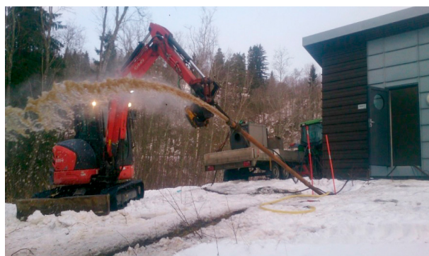
Figur 7-2. Rehabilitering av løsmassebrønn ved Støren vannverk med seksjonsvis filtertil trekking med mammutpumping. Vannet som spruter ut er vann som blåses opp mellom to pakninger i filteret (mammutpumping). Bildet til venstre er ved oppstart, mens bildet til høyre er etter ca. 4 timers rehabilitering (foto: Bernt Olav Hilmo).
