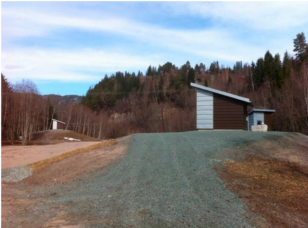
Figur 6-8. Brønnhus over tre løsmassebrønner ved Støren vannverk, Midtre Gauldal kommune. Brønnene er plassert nær et flomløp i Gaula og er bygd opp til over nivå for 1000-årsflom.
