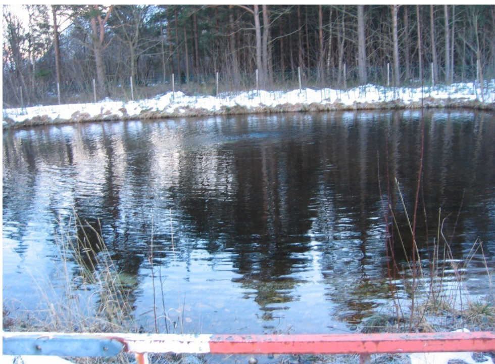
Figur 3. Bilde av infiltrasjonsbasseng. Vannet kommer inn midt i bassenget.
