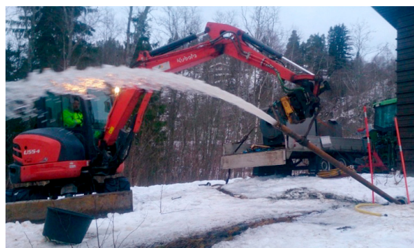
Figur 7-2. Rehabilitering av løsmassebrønn ved Støren vannverk med seksjonsvis filtertil trekking med mammutpumping. Vannet som spruter ut er vann som blåses opp mellom to pakninger i filteret (mammutpumping). Bildet til venstre er ved oppstart, mens bildet til høyre er etter ca. 4 timers rehabilitering (foto: Bernt Olav Hilmo).
