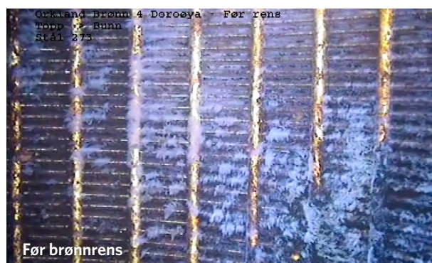
Figur 7-1. Kamerainspeksjon som viser brønnfilteret før (bildet til venstre) og etter brønnrehabilitering (bildet til høyre). Foto Gjævaag AS og Bernt Olav Hilmo.
