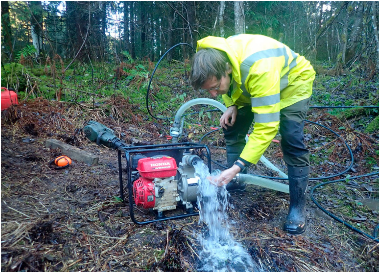
Figur 5-2. Nivåvis pumping under etablering av Ø32 mm undersøkelsesbrønn.
