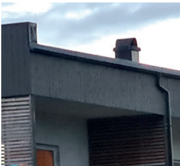
Figur 8-3. Kompakt tak med fall mot utvendig takrenne.
