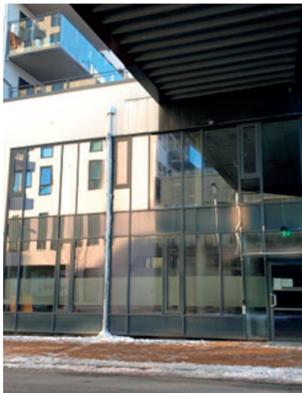
Figur 4-4. Damsgårdssundet i Bergen, februar 2021, etter ca. to uker med vedvarende minusgrader. Nedløpsrøret er innkapslet i is. Foto: Bjarne Høstmark
