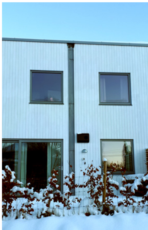
Figur 15: Venstre: Taknedløp med svært stor diameter, fra St. Petersburg i Russland (Skjermdump fra Google Street View, ©Google 2023). Høyre: Taknedløp utformet som innfelt renne i fasaden (Foto: Ivar Andenæs).
