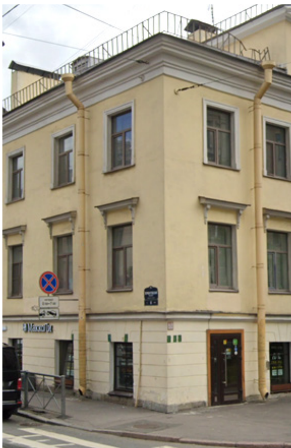
Figur 15: Venstre: Taknedløp med svært stor diameter, fra St. Petersburg i Russland (Skjermdump fra Google Street View, ©Google 2023). Høyre: Taknedløp utformet som innfelt renne i fasaden (Foto: Ivar Andenæs).
