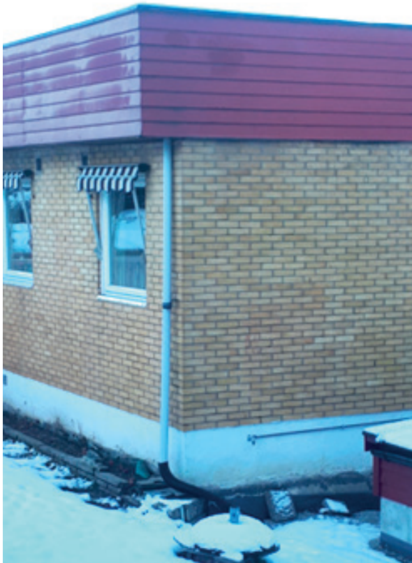
Figur 8-1. Utvendig nedløp fra sluk ved parapet.
