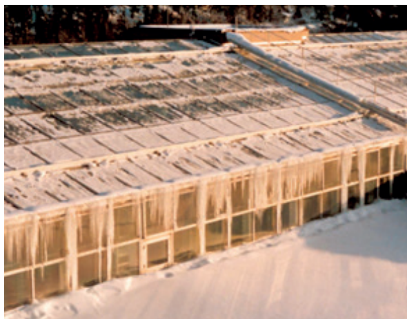
Figur 4-3. Snøsmelting på glasstaket har ført til ising når vannet treffer en kaldere del av taket. Foto: Erik Algaard
