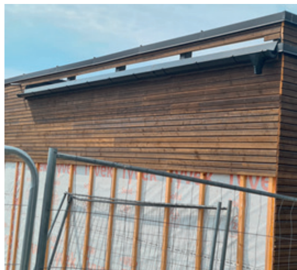
Figur 8-4. Slisse i parapet med utvendig takrenne.
