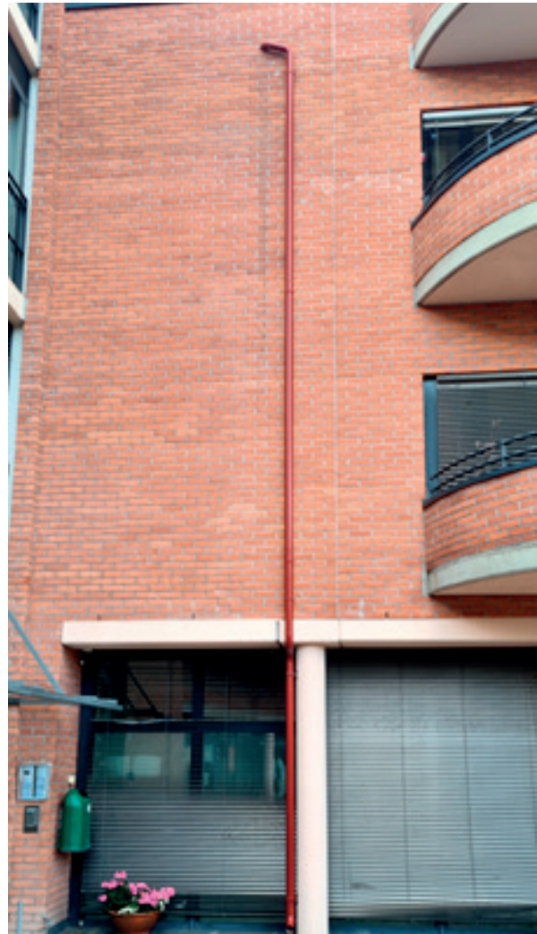
Figur 8-2. Sluk på terrasse over oppvarmet areal.
