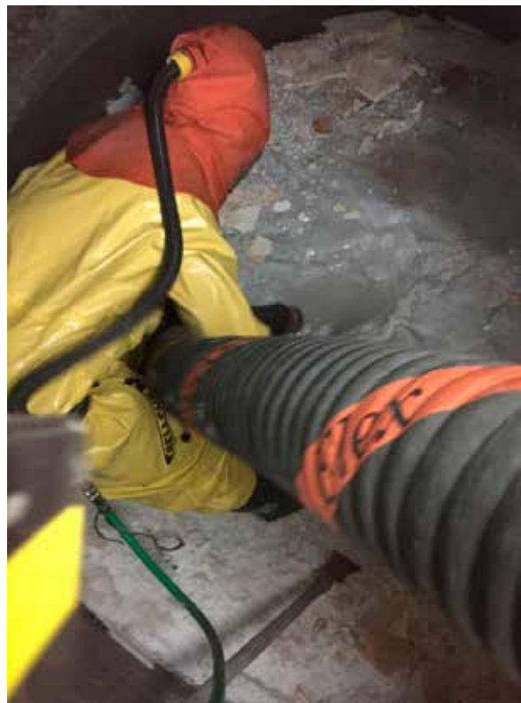
Figur 11. Bunnfall suges opp fra en lagertank for natronlut som ikke er vedlikeholdt på svært mange år.
