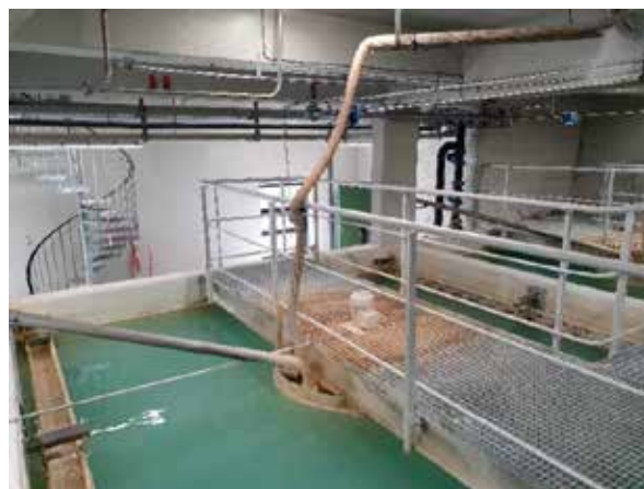
Høyre: Kalkvannsbereder
