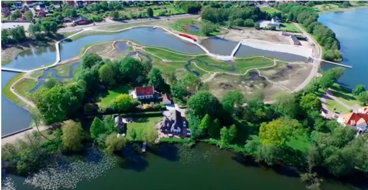
Figur 6: sØnæs som nyetablert i en flomsituasjon, der store deler av arealene er dekket av vann og vannlinje som krysser flomarealene trer tydelig frem. Ingen av disse har rekkverk. Dette er vurdert å være akseptabelt ettersom anlegget grenser opp mot en stor naturlig vannforekomst. (foto: Realdania.dk).
