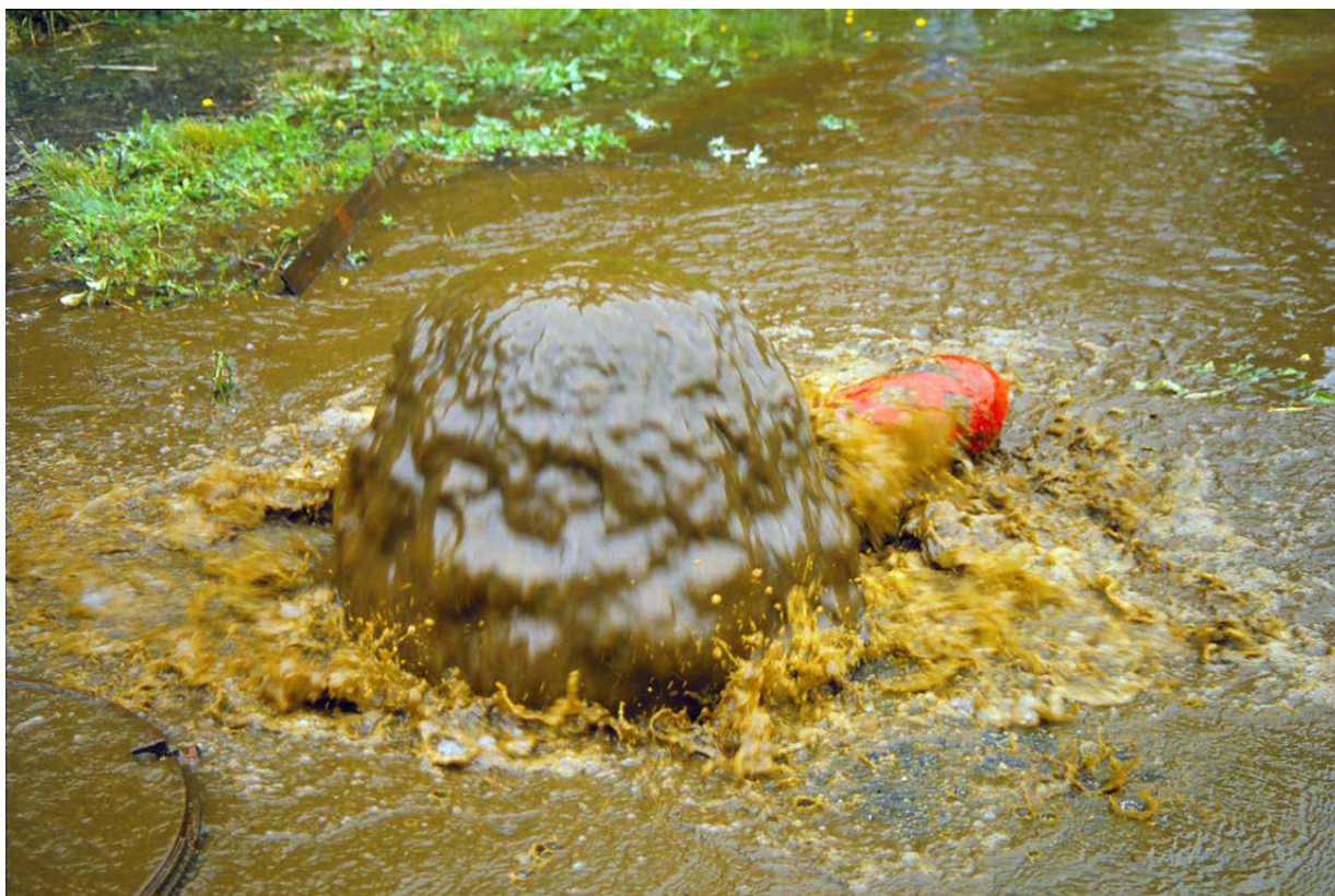
Figur 6: Det er viktig å ha et opplegg for håndtering av spylevannet ved pluggkjøring om det må føres opp av kummen så man unngår forsøpling og miljøskader.
