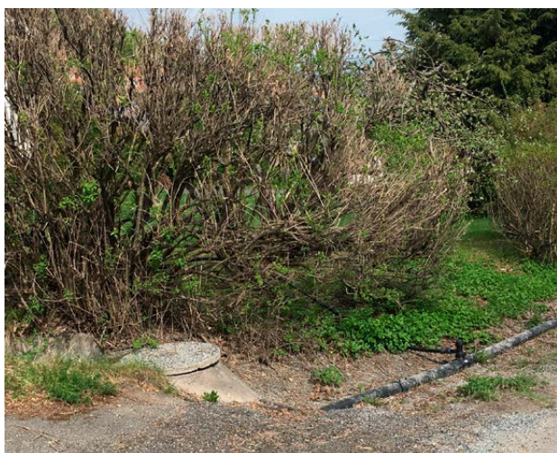
Figur 3: Provisorisk vannforsyning i veigrøft og hagekrantilkobling.
