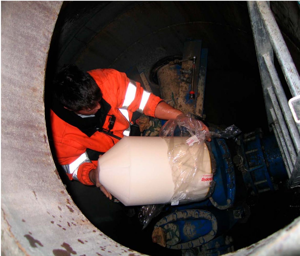
Figur 4: Fjerning av innpakkingsplast fra rensepluggen rett før innlasting i ledningen.
