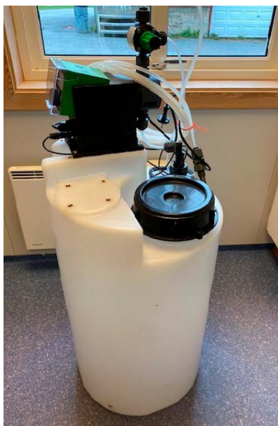
Figur 8: Enkelt utstyr for desinfisering med flytende klor. Klortank, doseringspumpe, vannmåler med slanger og tilkoblingsdeler.
