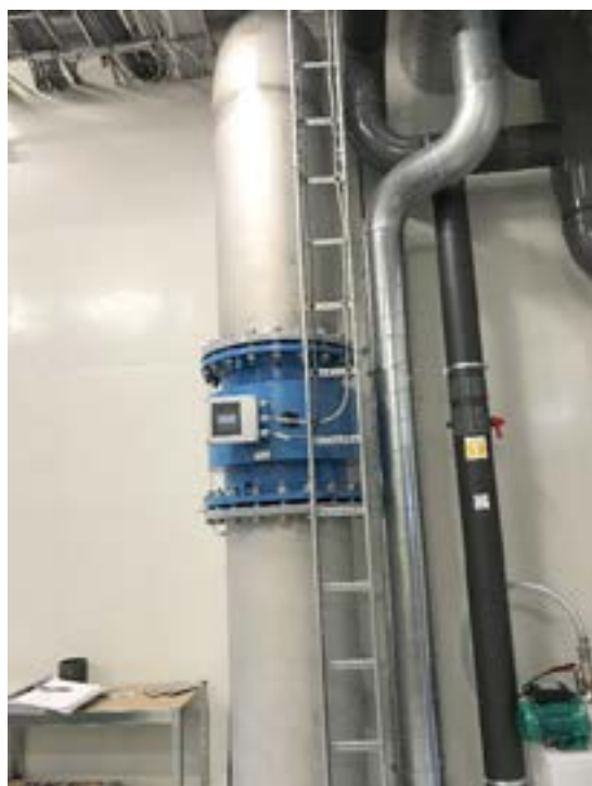
Figur 5 Elektromagnetiske mengdemålere på avløpsrenseanlegg – eksempel på krav til installasjon og usikkerhet.
