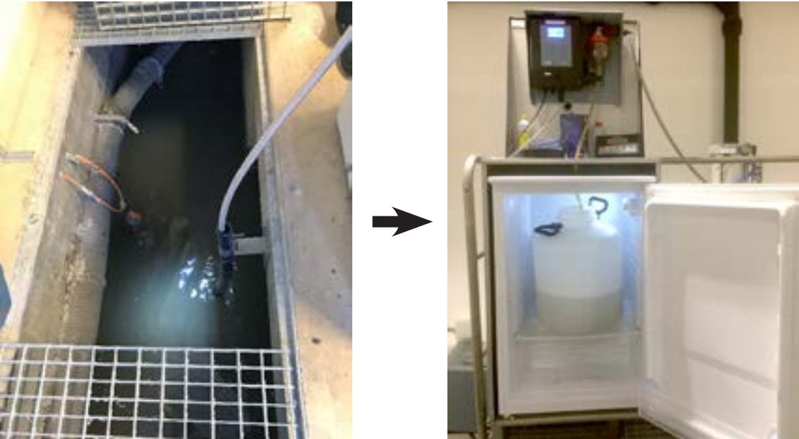
Figur 12 Primærprøvetaking med automatisk prøvetaker
