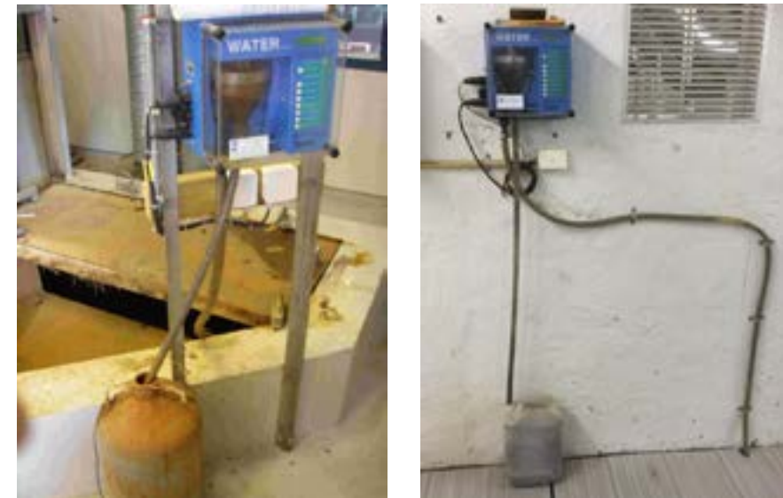
Figur 1 Eksempler fra førstegangskartlegging av renseanlegg – prøvetakingen vil ikke gi representativ prøve og flere tiltak måtte gjennomføres
