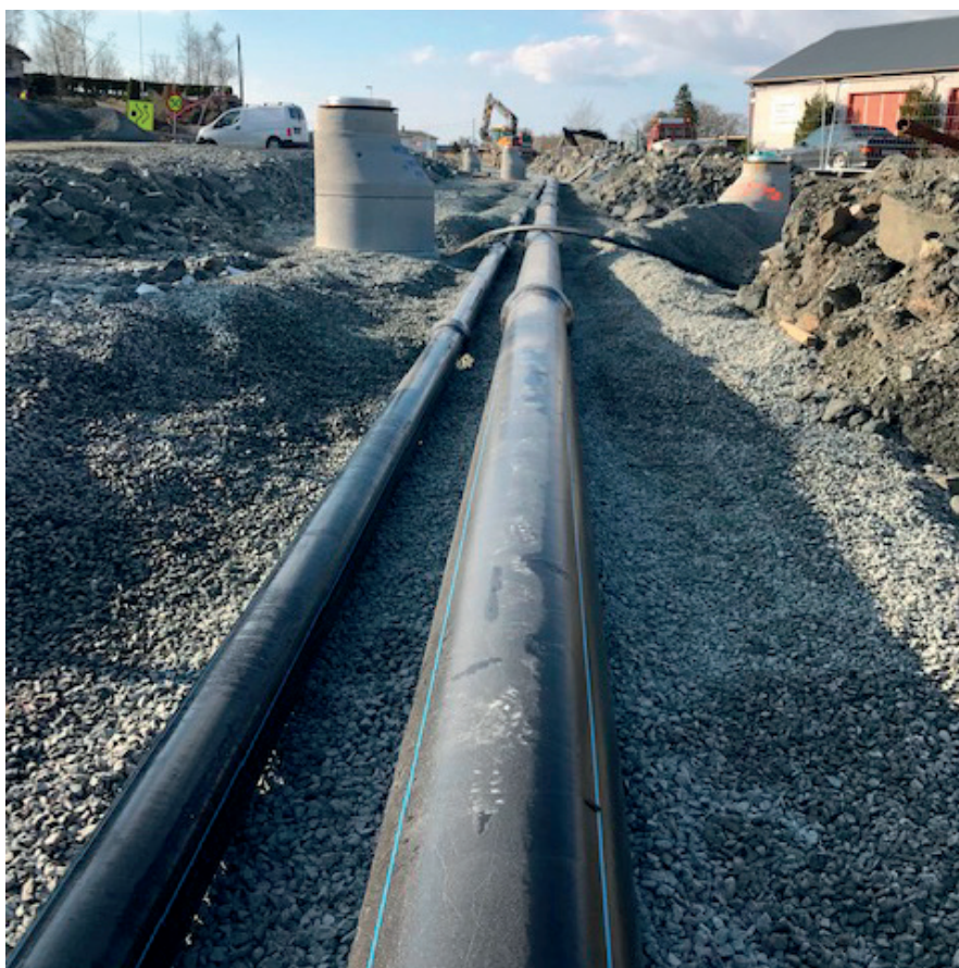
Figur 21: God grøfteutførelse har stor betydning for rørledningens levetid (foto: PAM).
