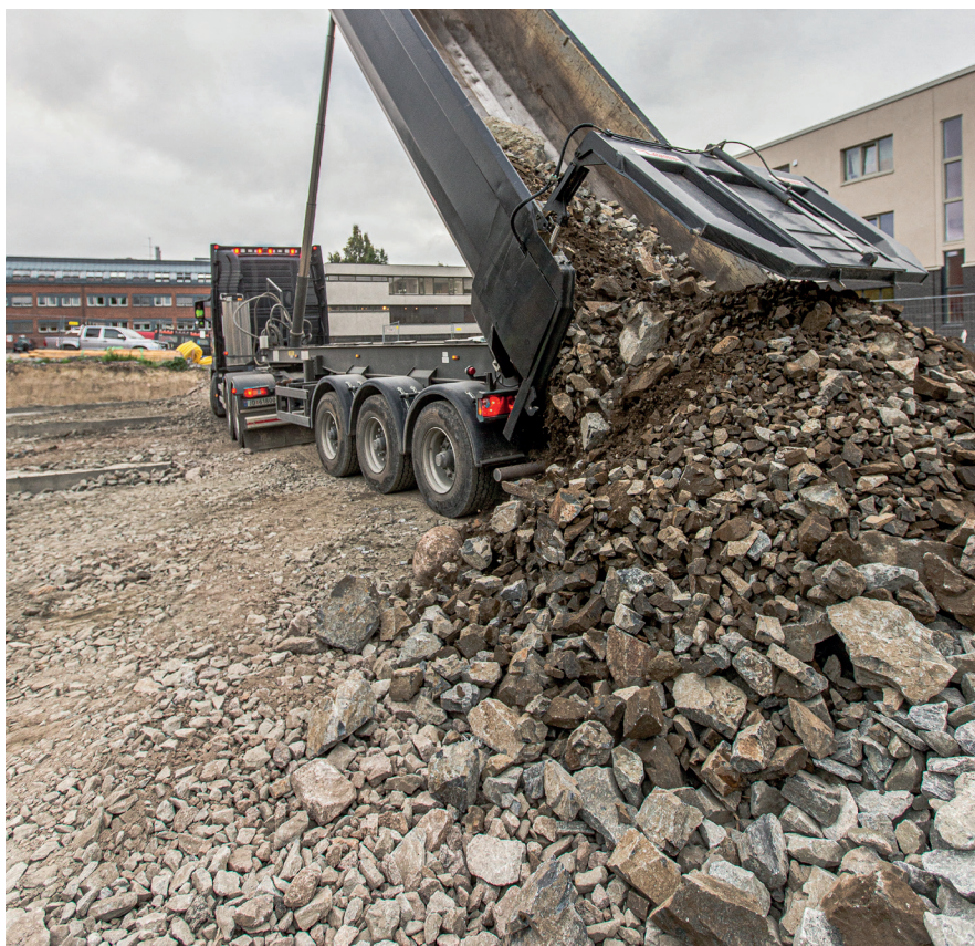
Figur 22: Lokale masser må ofte sorteres før bruk ved å sikte ut finstoff og for stort/grovt materiale
