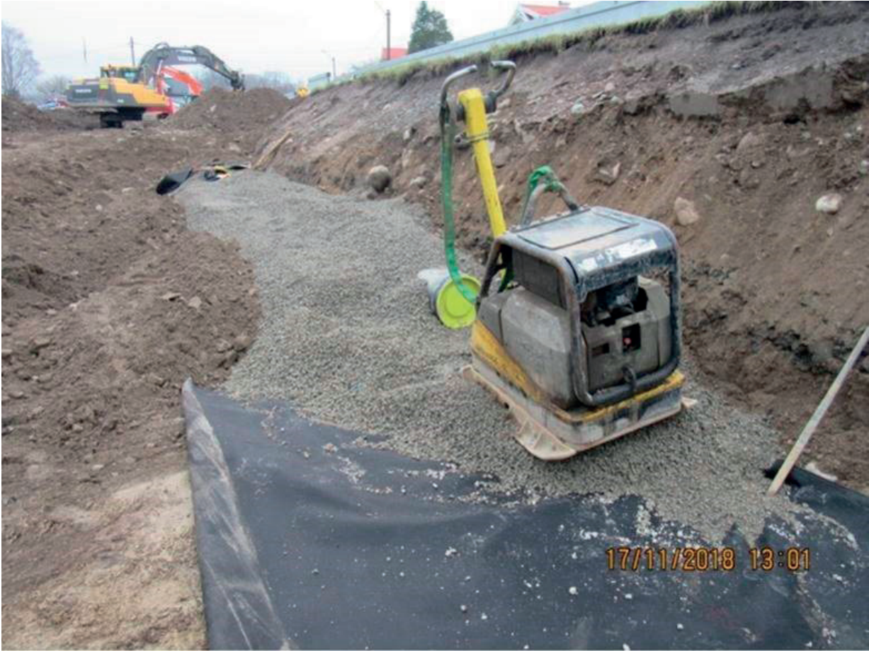
Figur 13: Komprimering av masser (foto: Norsk Vann/Gunnar Mosevoll).
