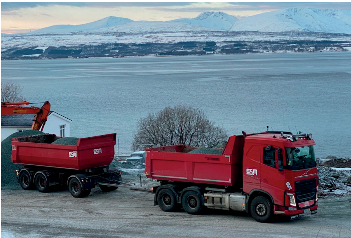
Figur 1: Massetransport i forbindelse med grøftarbeider representerer den største miljøbelastningen. (Foto: Einar Sørensen Maskinentreprenør AS)
