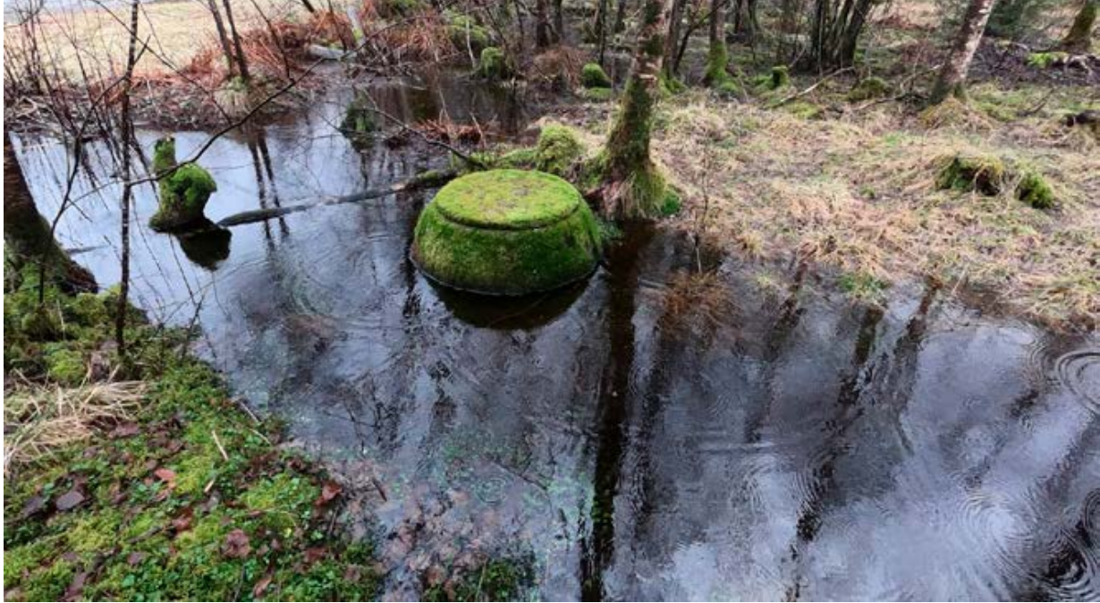
Figur 2-8 Ledninger som går gjennom myrområder med høy grunnvannstand har ofte store problemer med fremmedvann (Foto: Bergen kommune)
