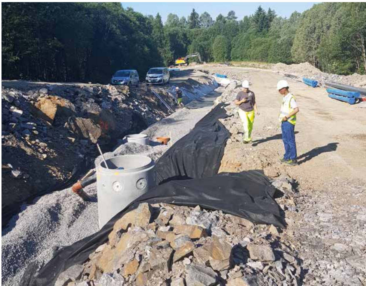
Figur 10. Etablering av VA-anlegg.
