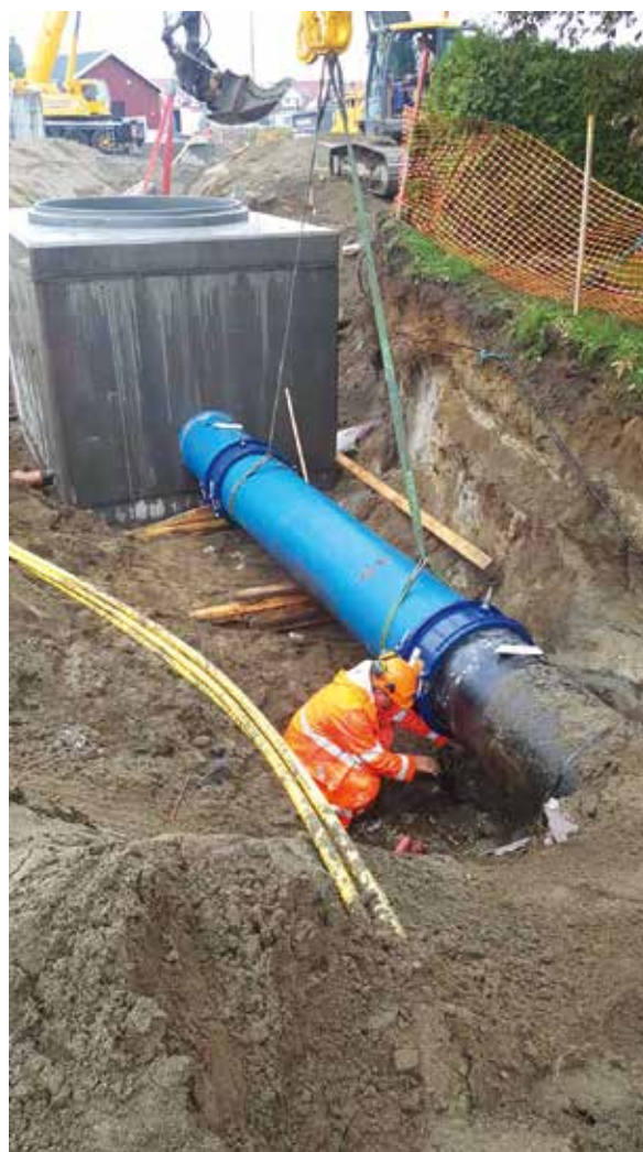
Figur 12. Legging av ny hovedvannledning.
