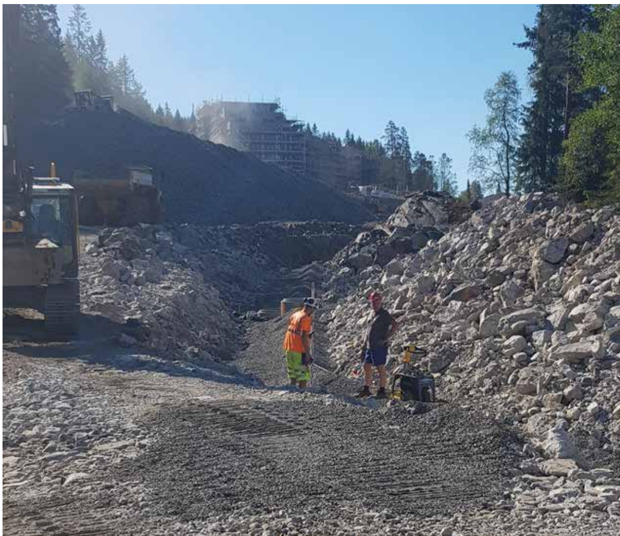
Figur 11. Fremføring av VA-ledninger til nytt boligfelt.
