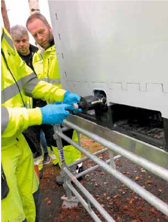
Figur 3: Tappekran monteres med hansker, steril innerpose monteres, øvelse: Foto: Monica Gudim.
