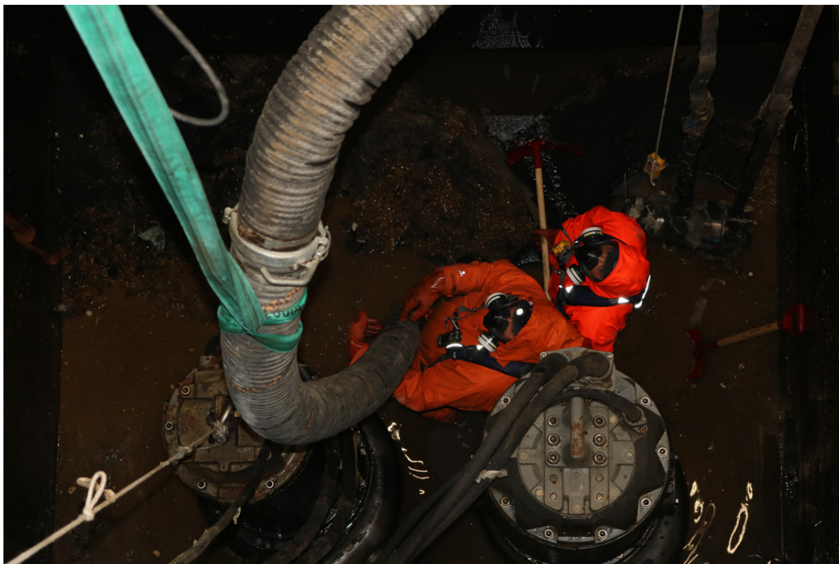
Bilde 6 Arbeid i pumpestasjon (Foto: IVAR IKS)
