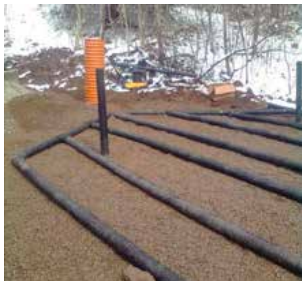
Fordeling av slamavskilt avløpsvann med selvfall via grenrør i bakken – gir dårlig fordeling ut i infiltrasjonsrørene
