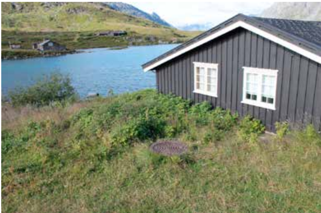
Frodig vegetasjon, med bl.a. bringebær mellom slamavskiller og vassdrag, som indikerer at den eldre plasstøpte slamavskilleren ikke er helt tett.
