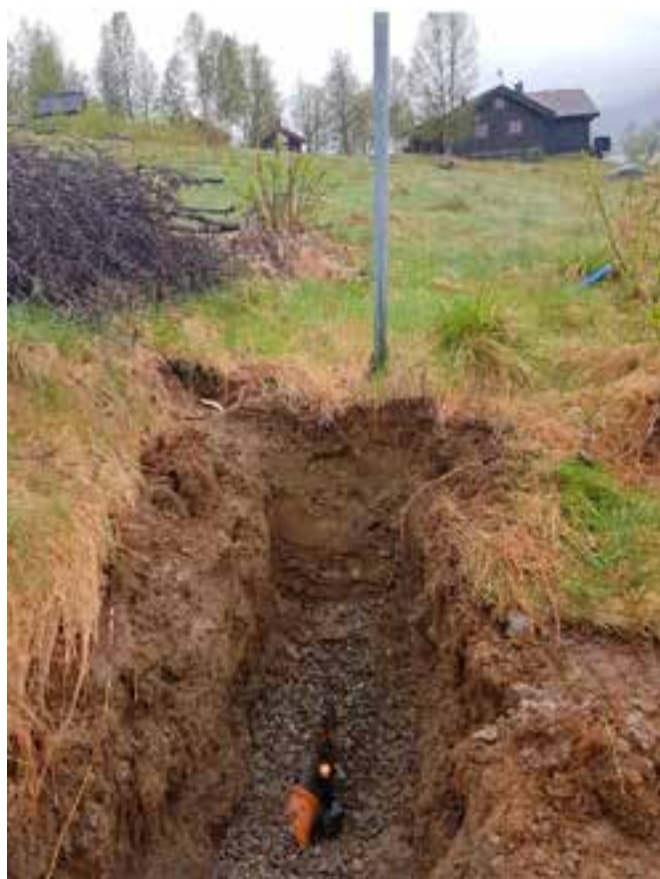
Lukket infiltrasjonsanlegg for hyttefelt med 20 hytter. Kontroll av infiltrasjonsgrøfter i morenemasser. Anlegget er lavt belastet, og det ble ikke registrert oppstuvning av avløpsvann i grøftene.
