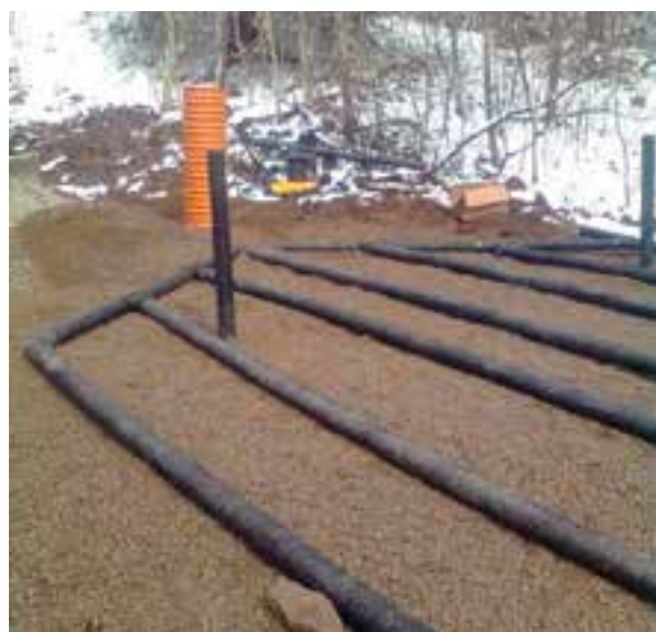
Fordeling av slamavskilt avløpsvann med selvføll via grennrør i bakken – gir dårlig fordeling ut i infiltrasjonsrørene
