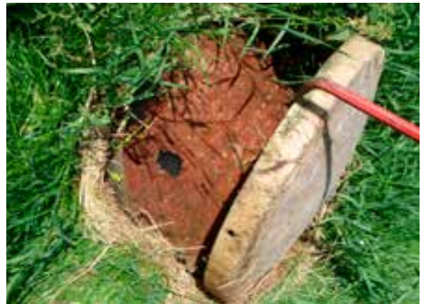
Tette infiltrasjonsgrøfter/-filtre medfører tilbakestuvning og høyt vannivå i eldre slamavskillere, slik at disse blir overfylt og avløpsvann renner direkte ut på terreng.
