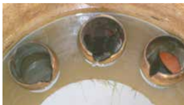
Fordelingskummer med fastmonterte utløpsrør, som ikke ligger i samme nivå – gir ujevn fordeling. Kummen til venstre er også gjenslemmet, grunnet dårlig drift og vedlikehold gjennom mange år
