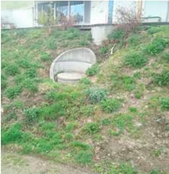
Slamavskiller etablert i skråning, med utslipp til infiltrasjonsfilter med utslag til veigrøft
