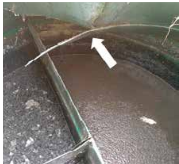
Glassfiber-/plastslamavskiller med brekkasje på grunn av ytre påvirkning, som eksempel gravemaskinskuff eller trykkbelastning fra jordmasser eller kjøretøy. Tanken til høyre er også lekk, da vannivå er lavere enn fettrand, som viser normal vannstand i kummen
