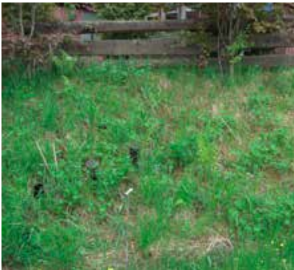
Tre parallelle infiltrasjonsgrøfter med enderør/kontrollrør, etablert i skråning like ved veigrøft. Bildet til høyre er tatt ned i det ene røret og viser at vannivå står like under terreng. Konklusjon er tett infiltrasjonsgrøft/-filter. Resultatet av dette er utlekking av slamavskilt avløpsvann direkte til veigrøft
