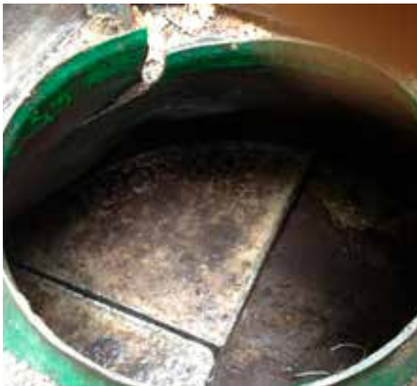
Glassfiber-/plastslamavskillere med brekkasje på grunn av ytre påvirkning, som eksempel gravemaskinskuff eller trykkbelastning fra jordmasser eller kjøretøy. Tanken til høyre er også lekk, da vannivå er lavere enn fettrand, som viser normal vannstand i kummen
