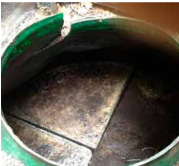
Glassfiber-/plastslamavskiller med brekkasje på grunn av ytre påvirkning, som eksempel gravemaskinskuff eller trykkbelastning fra jordmasser eller kjøretøy. Tanken til høyre er også lekk, da vannivå er lavere enn fettrand, som viser normal vannstand i kummen
