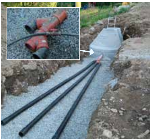
Fordeling av slamavskilt avløpsvann med selvfall via grenrør i bakken – gir dårlig fordeling ut i infiltrasjonsrørene
