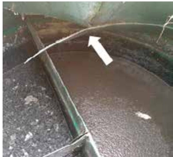
Glassfiber-/plastslamavskillere med brekkasje på grunn av ytre påvirkning, som eksempel gravemaskinskuff eller trykkbelastning fra jordmasser eller kjøretøy. Tanken til høyre er også lekk, da vannivå er lavere enn fettrand, som viser normal vannstand i kummen
