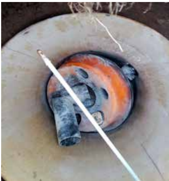
Selvjusterende fordelingskummer med flottør – rengjort og klare for bruk
