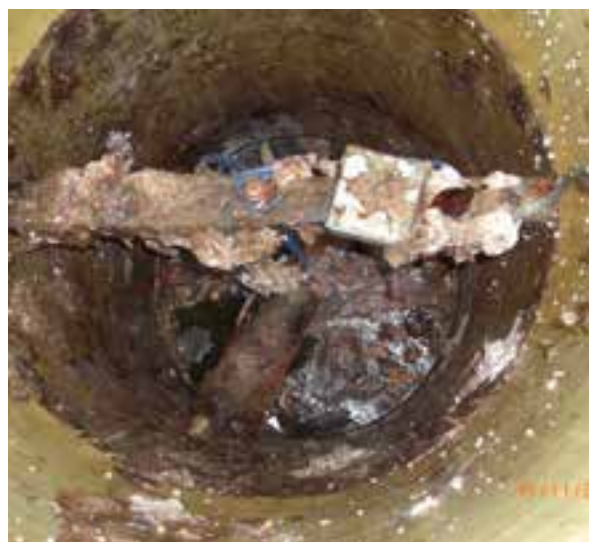
Pumpekummer med vippestyrt pumpe – pumpe har stoppet, alarm for høyt vannnivå har ikke fungert/ikke vært montert, og vannnivået har steget i kummene
