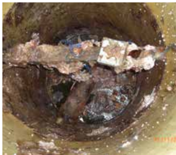
Pumpekummer med vippstyrt pumpe – pumpa har stoppet, alarm for høyt vannnivå har ikke fungert/ikke vært montert, og vannnivået har steget i kummene
