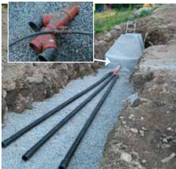
Fordeling av slamavskilt avløpsvann med selvføll via grennrør i bakken – gir dårlig fordeling ut i infiltrasjonsrørene
