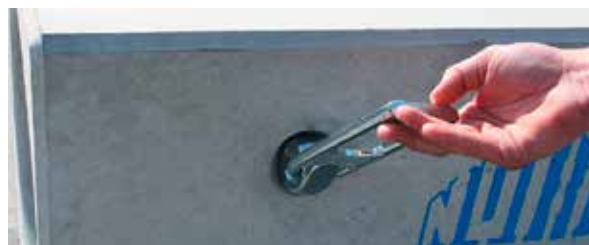
Figur 25: Feste av løftekrok til løfteanker
