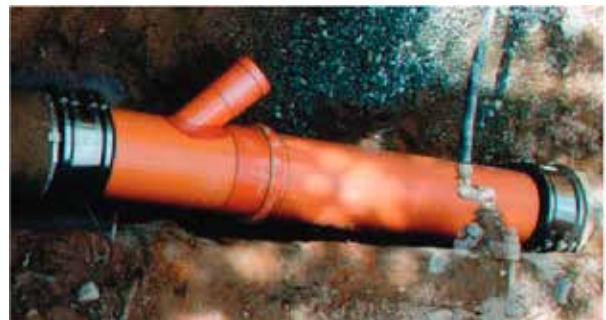
Figur 35: Skjøting av eksisterende betongrør med PVC/PP og grenrør
