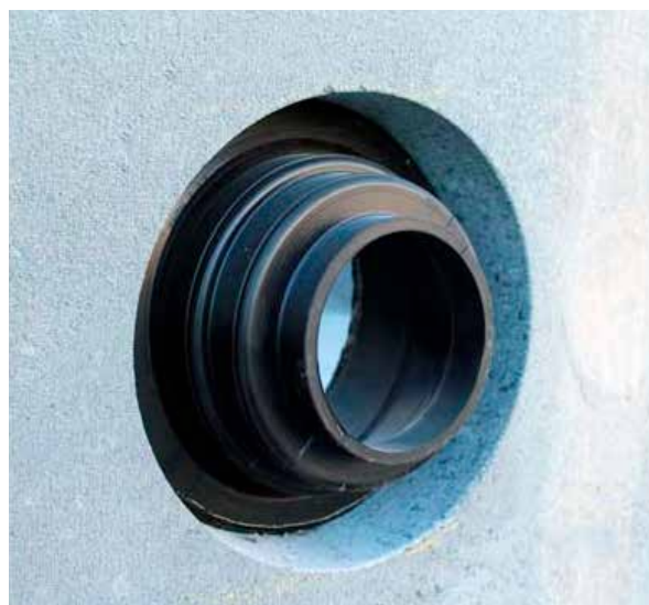
Figur 38: Kumgjennomføring med fleksibel pakning, type Kombipakning
