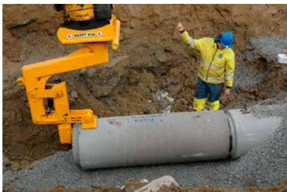
Figur 29: Leggeverktøy for mufferrør og falsrør, «Pipelifter»
