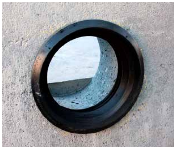
Figur 37: Kumgjennomføring med kompakt pakning, type AR
