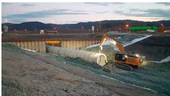
Figur 3. Nytt DN 3000 betongrør langs E6 i Melhus (Foto: Loe Rørprodukter)
