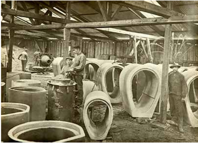
Figur 1: Produksjon av eggformede rør og utføring med keramiske fliser.
