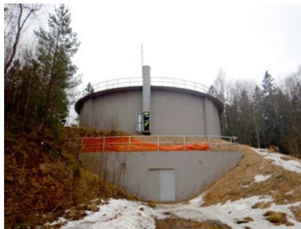
Figur 19 viser overflatebasseng utført i betong med heldekkende sylinder rundt stigen og hus på taket. (foto Ancistrus AS).
