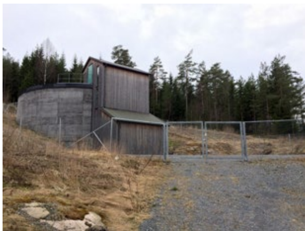
Figur 18 viser overflatebasseng utført i betong med påbygget trappetårn og perimetergjerde. (foto Ancistrus AS).
