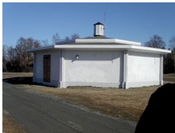
Figur 21 viser nedgravd høydebasseng med overbygd hus i trevirke. (foto Forsvarsbygg)
