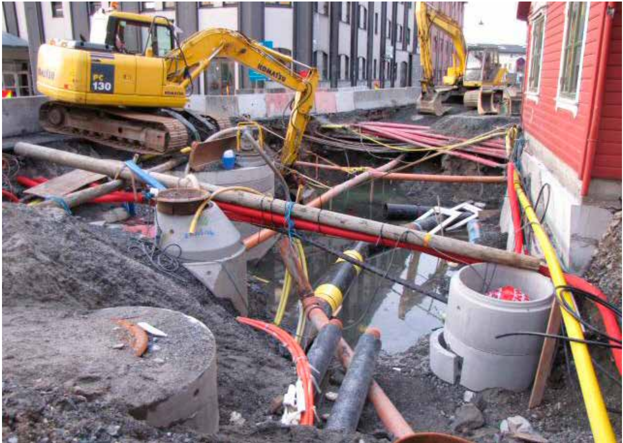
Figur 19: Graving i Nøstegaten i Bergen. Foto: Asplan Viak AS
