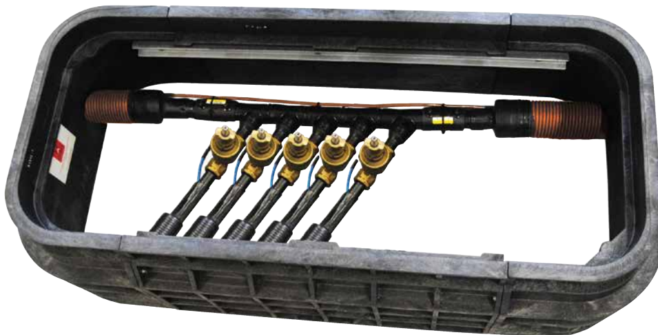
Figur 5: Eksempel på samleklum for trykkavløp. Foto: Isoterm
