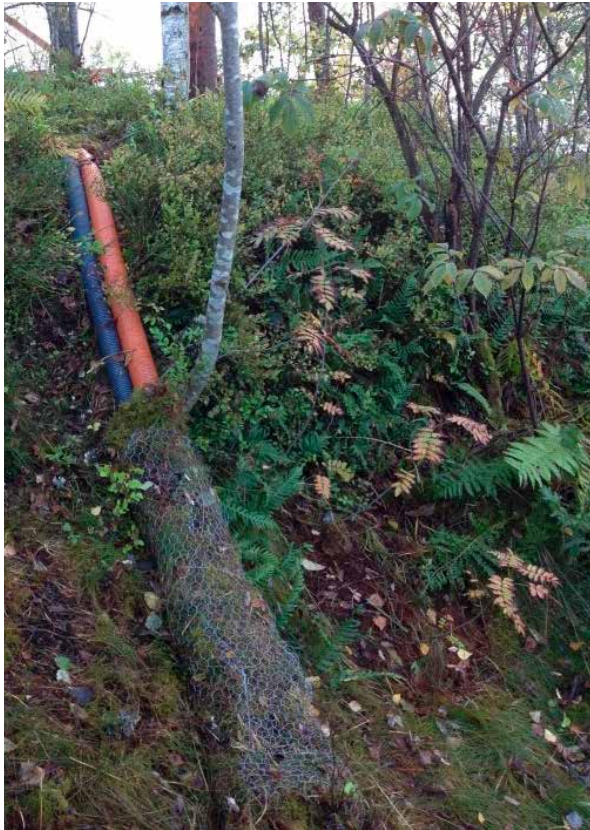
Figur 8: Eksempel på legging av trykkrør med varmekabel direkte på terreng med lokale materialer fra skogbunn som omfyllingsmasser for å skjule rørene. Foto: Skandinavisk Kommunalteknikk AS
