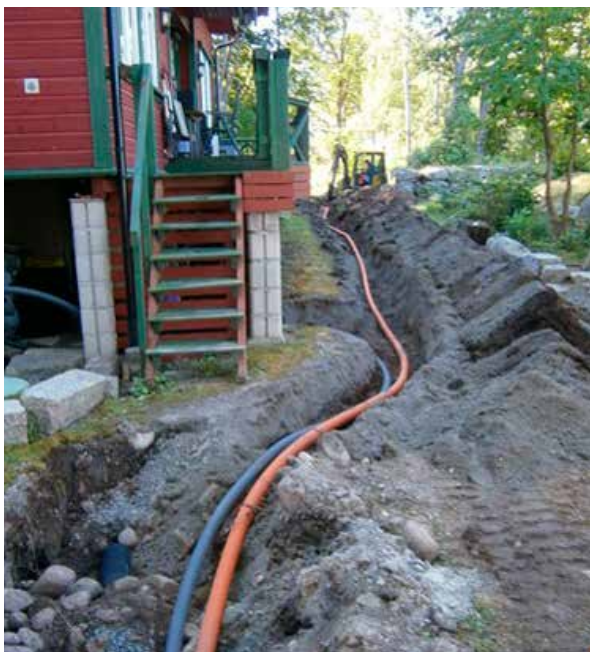
Figur 9: Trykkavløp og vannledning med varmekabel i varerør, lagt i grunn grøft. Foto: Skandinavisk Kommunalteknikk AS
