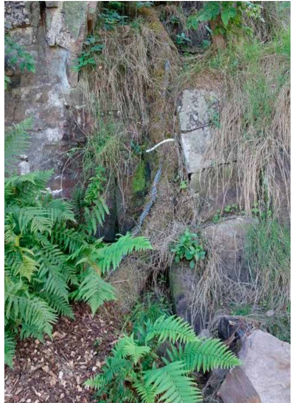
Figur 8: Eksempel på legging av trykkrør med varmekabel direkte på terreng med lokale materialer fra skogbunn som omfyllingsmasser for å skjule rørene. Foto: Skandinavisk Kommunalteknikk AS
