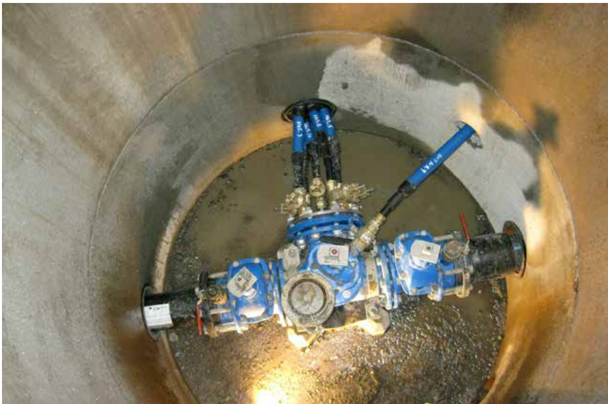
Illustrasjon 11: Narvik kommune har tatt i bruk tilsvarende kum som Voss kommune. Bildet viser hvordan denne type kum ser ut. Foto: Narvik VAR
