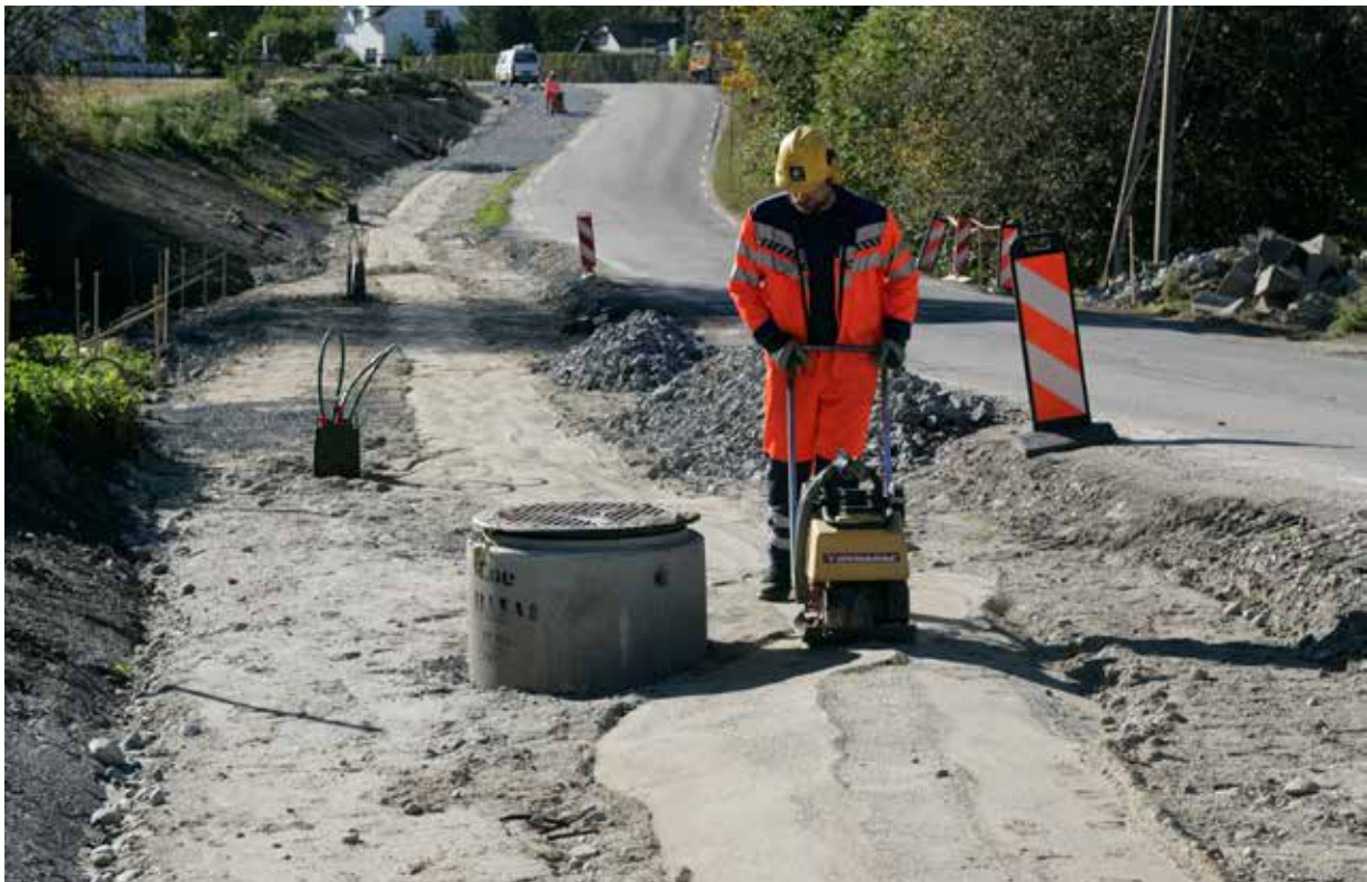
Illustrasjon 20: Det er enklere å reparere lekkasjer på stikkledninger som er knyttet til hovedledninger som ligger langs veigrunnen. Foto: NTB scanpix
