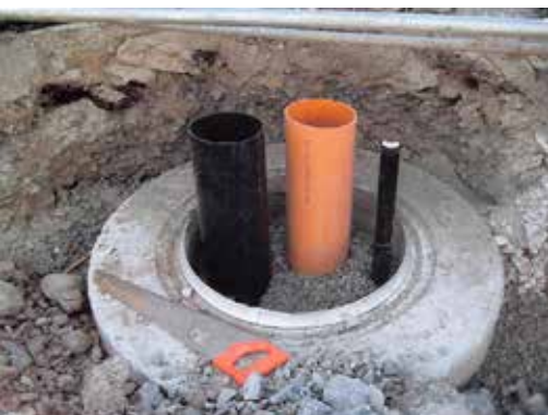
Illustrasjon 22: Eksempel på bunnløs overgangskum for å markere eiergrensesnitt Foto: Stavanger kommune
