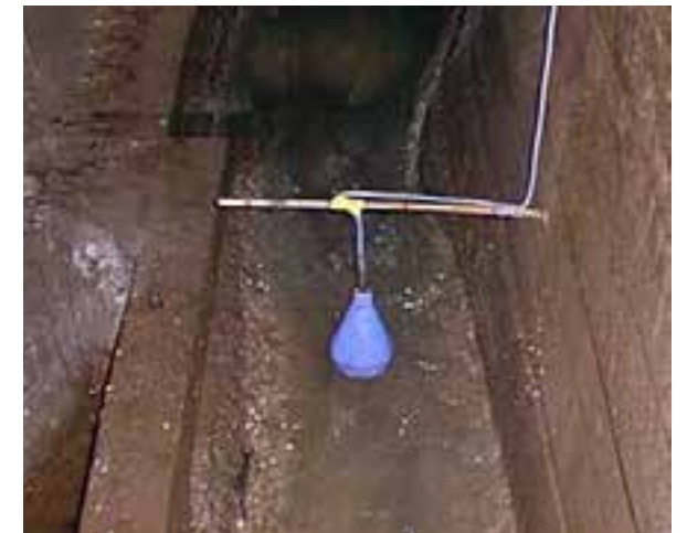
Figur 5.3.1: Overløpsvippe montert i overløp (privat bilde).
