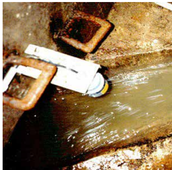
Figur 5.2.2: Ultralyd nivåmåler montert i kum (privat bilde).
