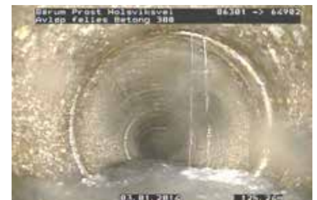
Rørinspeksjon er «ferskvare» og må alltid utføres i forkant av en installasjon av foring. Bilde av eksisterende ledning (Foto: Kjeldaas AS)
