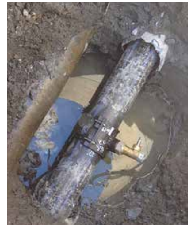
Tilkobling av stikkledning til nytt inntrukket rør (Foto: Borg Medier AS)
