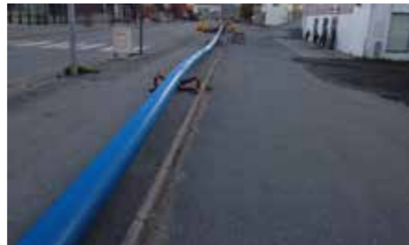
Ledning ligger klar for inntrekking (Foto: Vestvågøy kommune)
