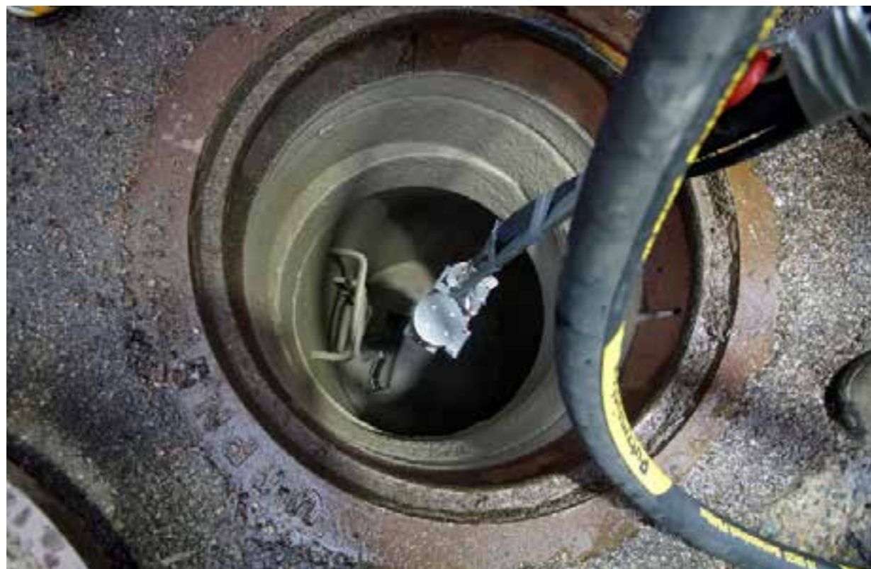
Påføring av sprøytebetong (Foto: Trondheim kommune)
