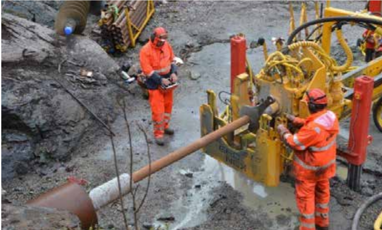
Boring i kombinert fjell og løsmasse. Det trekkes med stålrør i borehullet (Foto: Borg Medier AS)
