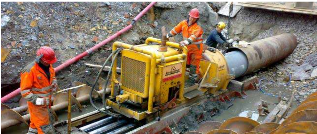
Rigg for rørpressing montert på fundament som normalt bygges ca. 0,4 m under rør som skal presses (Foto: Borg Medier AS)
