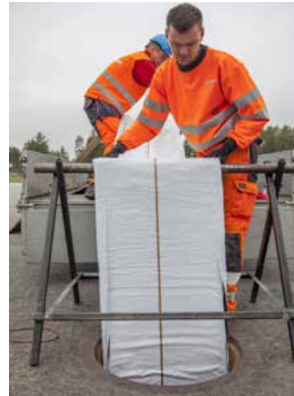
Klargjøring av foring før inntrekking i rør som skal fornyes (Foto: Kjeldaas AS)
