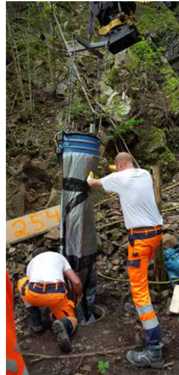
Foring monteres fra bakkenivå via kumlokk (Foto: Sweco AS)
