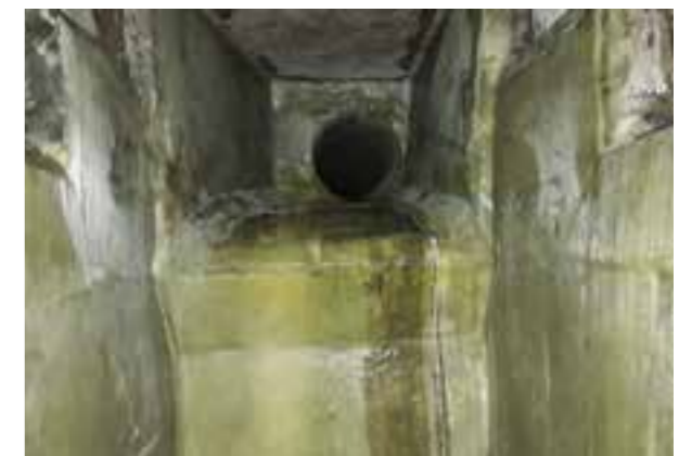
Stor kumkonstruksjon ferdig fornyet med plater (Foto: Kjeldaas AS)
