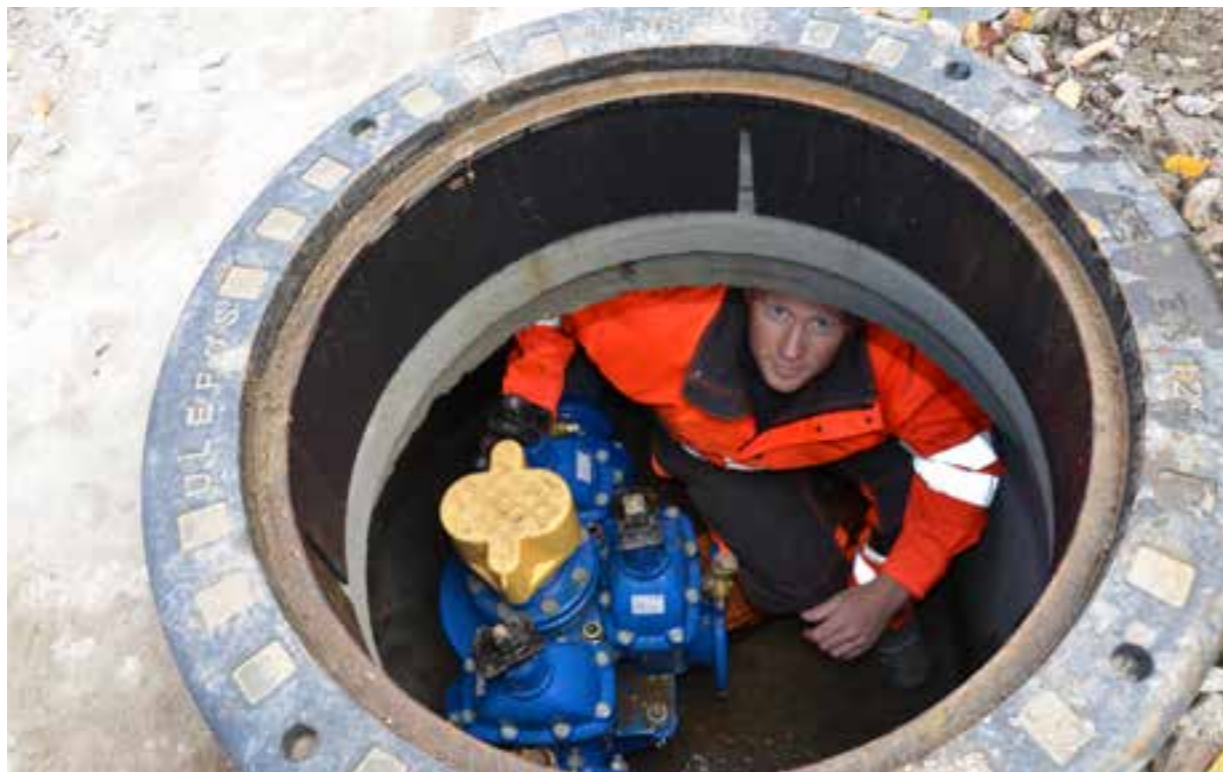
Kummene må ikke glemmes under arbeidet med fornyelse av ledningsnett (Foto: Borg Medier AS)
