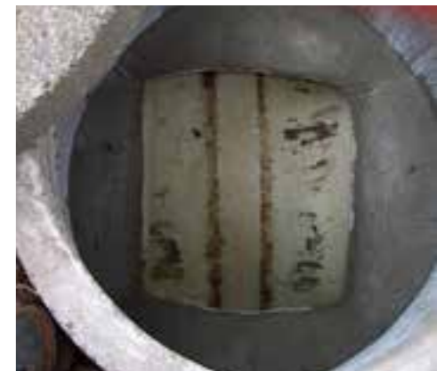
Strømpeforing installert gjennom eksisterende kum. Ryggen på foringen skjæres av og ny åpen renne i kummen er etablert (Foto: Kjeldaas AS)
