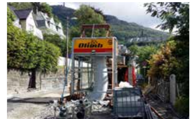
Innføring av strømpe via kum (Foto: Bergen kommune)
