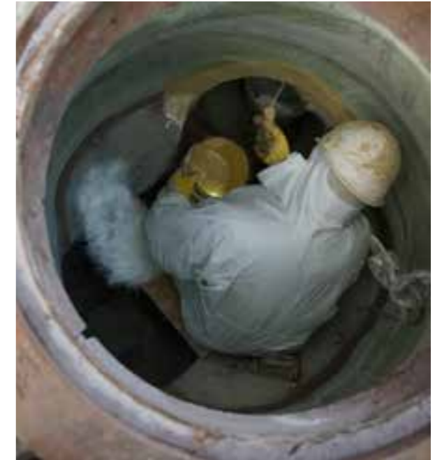
Lokal reparasjon av kumgjennomføring og renneløp (Foto: Kjeldaas AS)
