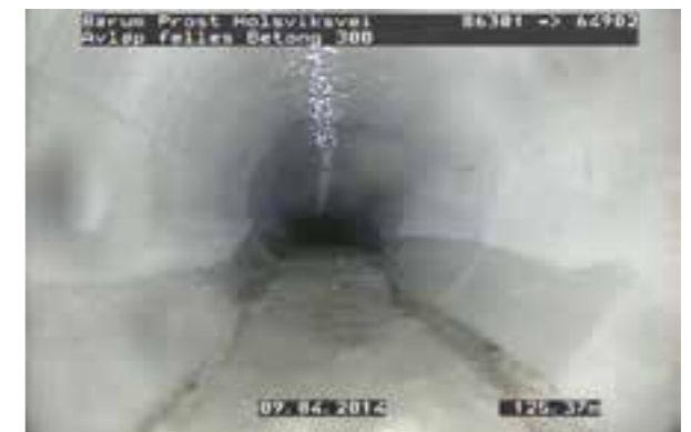
Bilde av samme ledning etter avsluttet installasjon av foring (Foto: Kjeldaas AS)
