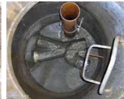
Kum etter fornyelse med nye renner og generell innvendig puss og reparasjon
