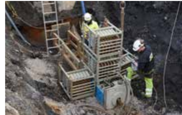
Trekkestenger påmonteres kniver, utvidere og den nye ledningen. Det hele trekkes inn i det eksisterende røret som da splittes og blokkes ut og gir plass til den nye ledningen (Foto: Borg Medier AS)
