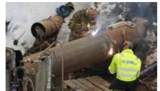
Sveising av stålrør som skal benyttes under presseoperasjonen (Foto: Borg Medier AS)
