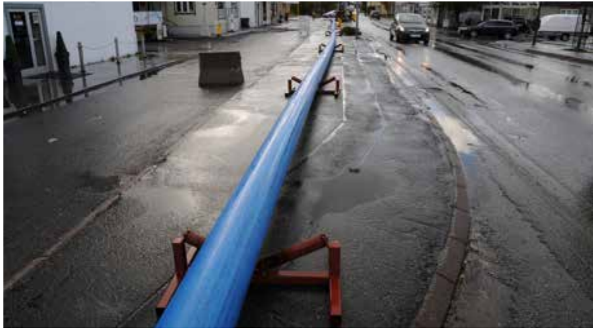
Sveiset PE-rør med beskyttelseskappe klar for installasjon. Ledning er lagt opp på «ruller» som beskytter mot mulige skader fra hardt underlag (Foto: Asplan Viak AS)
