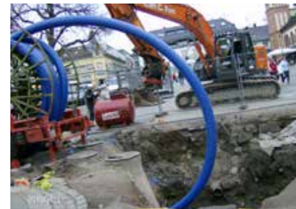
Installasjon av PE-rør levert på kveil innebærer et komprimert og avgrenset anleggsområde (Foto: Borg Medier AS)
