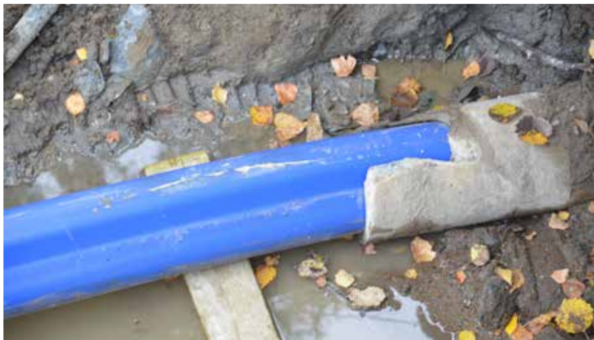
Tettisluttet rør inntrukket i eksisterende rør (Foto: Borg Medier AS)
