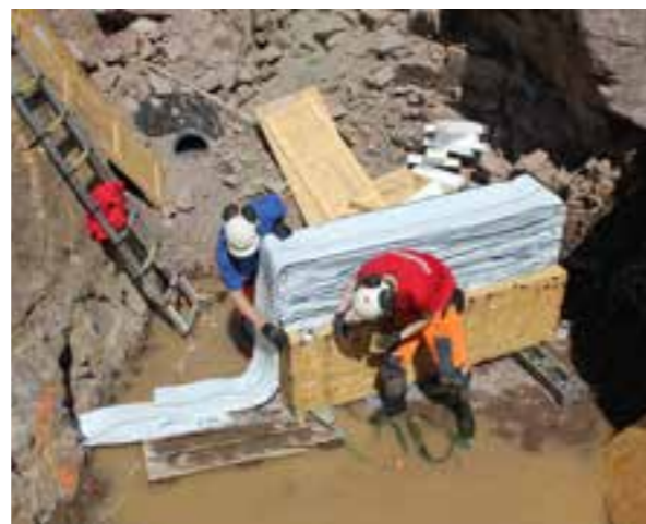
Innføring av strømppen i borehull (Foto: Kjeldaas AS)
