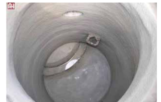
Bilde før og etter belegg (Foto: NoDig Miljø)
