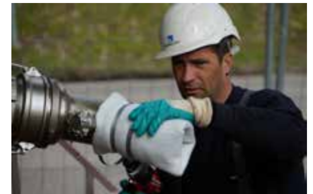
Utstyr for fornying av stikkledninger for avløpsledning (Foto: Borg Medier AS)
