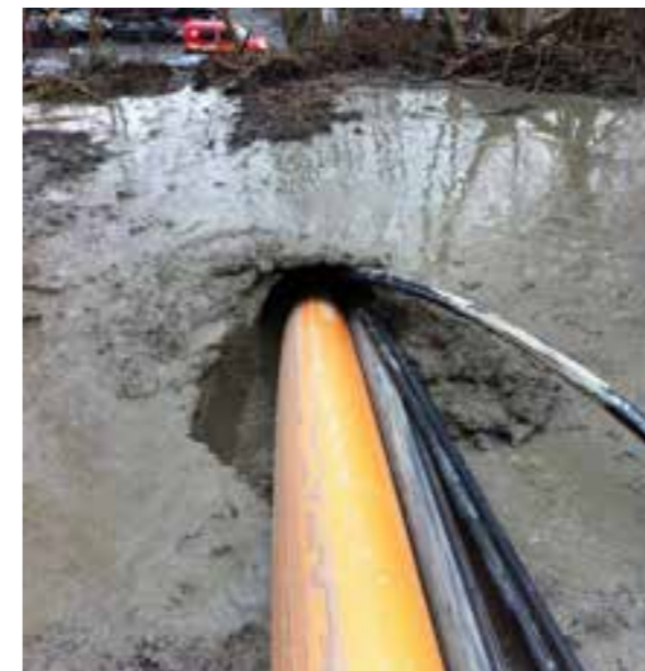
Inntrekking av medierør fra terrenget. Flere ledninger kan trekkes inn samtidig (Foto: Sweco AS)
