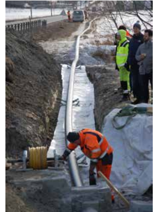
Inntrekking av rør (Foto: Kjeldaas AS)
