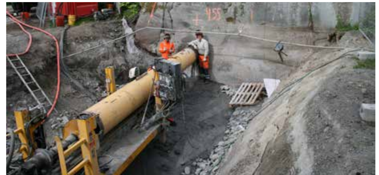
Oppstilling av borerigg (Foto: Borg Medier AS)
