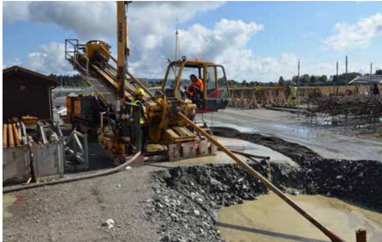
Ansett av pilotstreng fra terrengoverflaten (Foto: Borg Medier AS)
