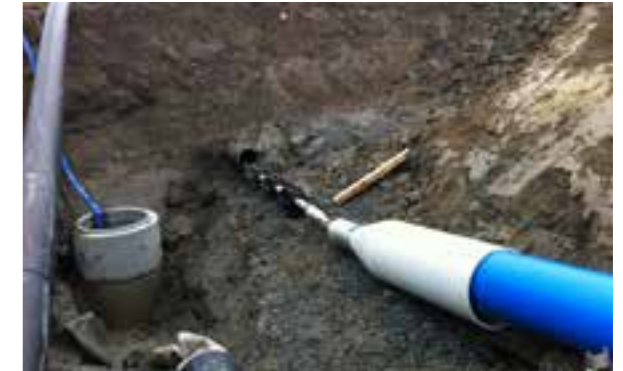
Innføringsgrop. Nytt medierør klargjort for innføring i eksisterende rør via første trekkestag med trekkenippel, skjæreutstyr og utvider (ekspander). (Foto: Borg Medier AS)
