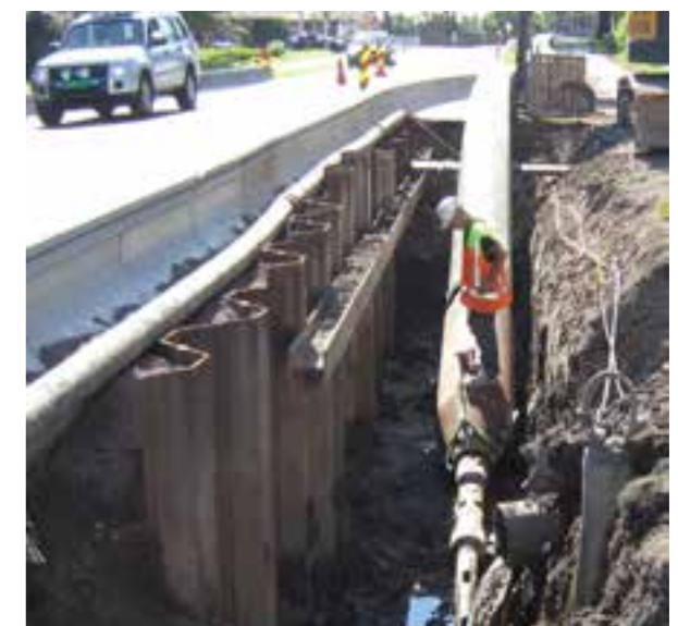
Kompliserte grunnforhold, samt 30 000 trafikkpasseringer i døgnet, da Natterøy kommune etablerte nytt VA-anlegg på en strekning av 680 meter med styrt boring og utblokking. 146 meter utblokking fra 440 mm til 630 mm (Foto: Borg Medier AS)
