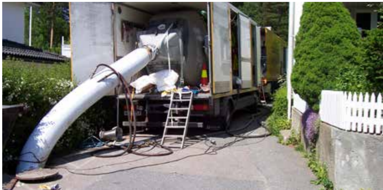
Installasjon av strømpeføring. Normal installasjon skjer fra kum til kum (Foto: Borg Medier AS)
