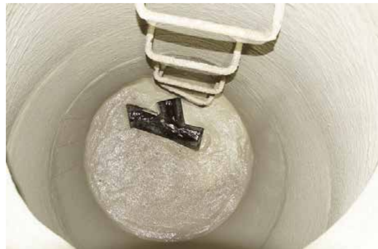
Ferdig fornyet avløpskum (Foto: NoDig Miljø - Steinsentre AS)
