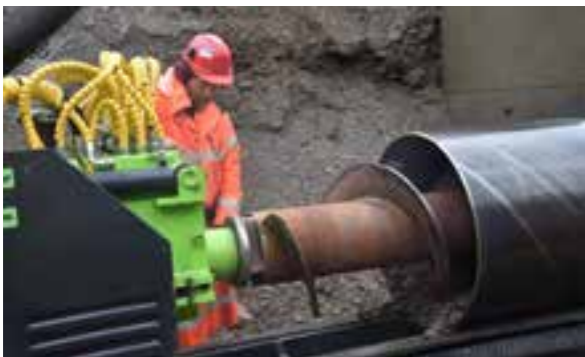
Ved boring i kombinasjonsmasser benyttes en skrue for uttransport av masser fra borehull (Foto: Borg Medier AS)
