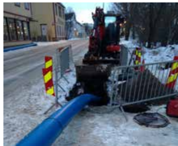
Ledning trekkes inn i innføringsgrop (Foto: Vestvågøy kommune)
