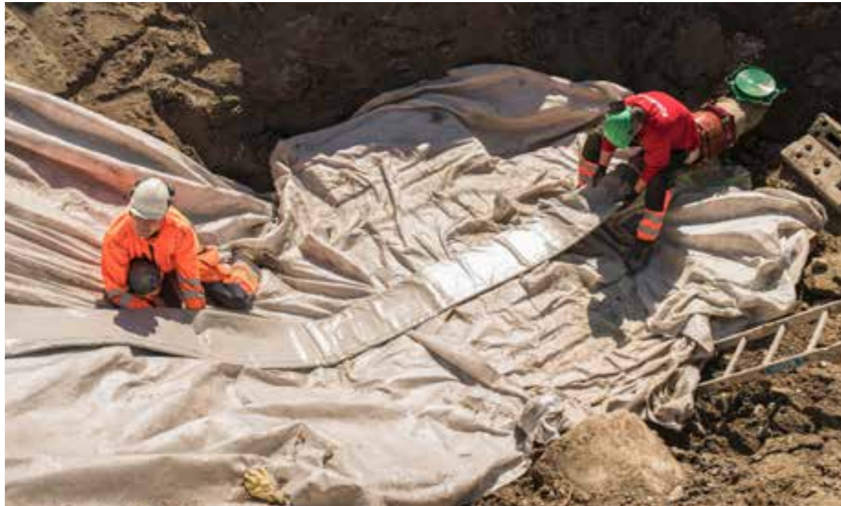
Installasjon av glassfiberarmert foring (Foto: Borg Medier AS)
