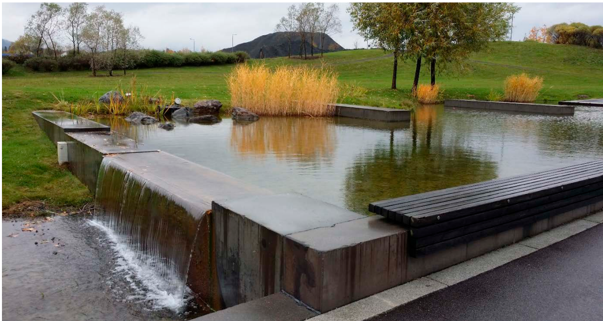
Figur 6: Vannrennen som går fra Tårnplassen ned til Nansendammen. Her pumpes vannet om sommeren for å sikre oksygentilførsel. Foto: Sweco
