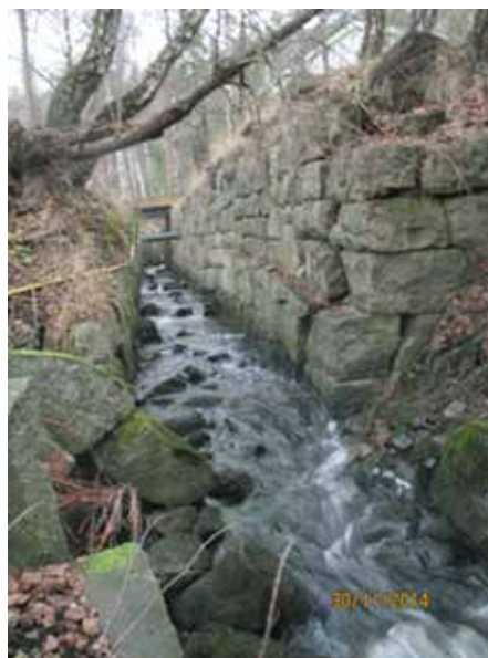
Figur 7.7. Nedre del av Åletjernbekken i Skien. Bekken går i løsmasse. Bekken ble godt sikret, da det i 1880 ble bygget en cellulosefabrikk her. Kanalen og den øvrige erosjonssikringen trenger av og til vedlikehold. Foto: Gunnar Mosevoll
