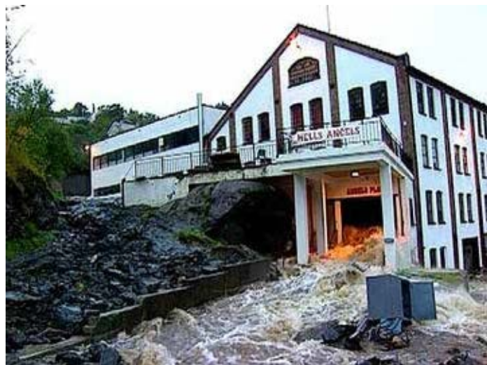
Figur 23. Eksempel på flomveg ved Trolla i Trondheim. Flomveg for scenarioet «tett kulvert» er vist rundt bygning. Til høyre bilde fra flom i Trolla 22.09.04 hvor bekken rant gjennom bygningen.
