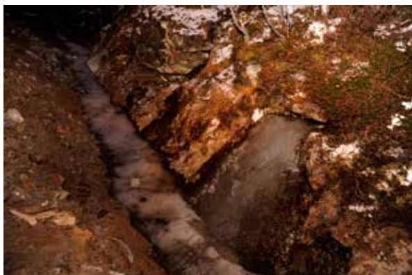
Figur 46. Grunnvann som fryser til i åpen grøft (foto: Tromsø kommune)
