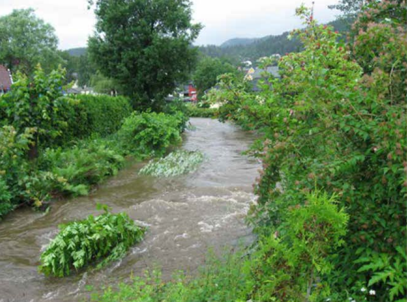
Figur 49. Gjengrodd bekkeløp gir redusert hydraulisk kapasitet (foto: Norconsult)
