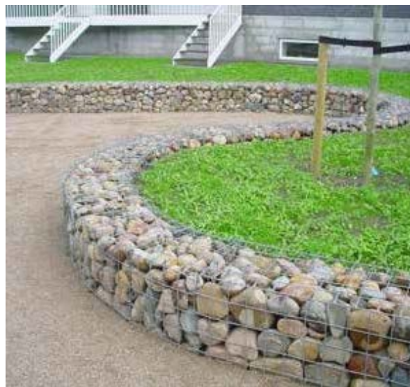
Figur 47. Grøftemasser (Glasopor) i en frostfri overvannsgrøft prøvd ut i Tromsø kommune (Tromsø kommune, 2013). Til høyre er det vist gabioner som en vil prøve ut i nye prosjekter hvor Glasopor (istedenfor stener) legges inn i finmasket gabioner slik at en slipper duk mellom massene.
