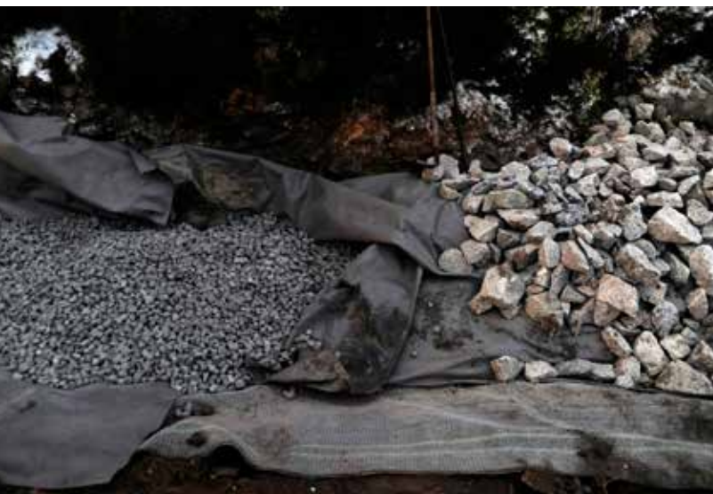
Figur 47. Grøftemasser (Glasopor) i en frostfri overvannsgrøft prøvd ut i Tromsø kommune (Tromsø kommune, 2013). Til høyre er det vist gabioner som en vil prøve ut i nye prosjekter hvor Glasopor (istedenfor stener) legges inn i finmasket gabioner slik at en slipper duk mellom massene.
