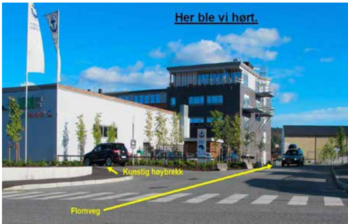
Figur 29. Eksempel fra Porsgrunn hvor en har laget et kunstig høybrekk og en betongmur inn mot et butikkssenter for å unngå at overflatevann ledes inn mot bygningen. (Foto: Porsgrunn kommune)
