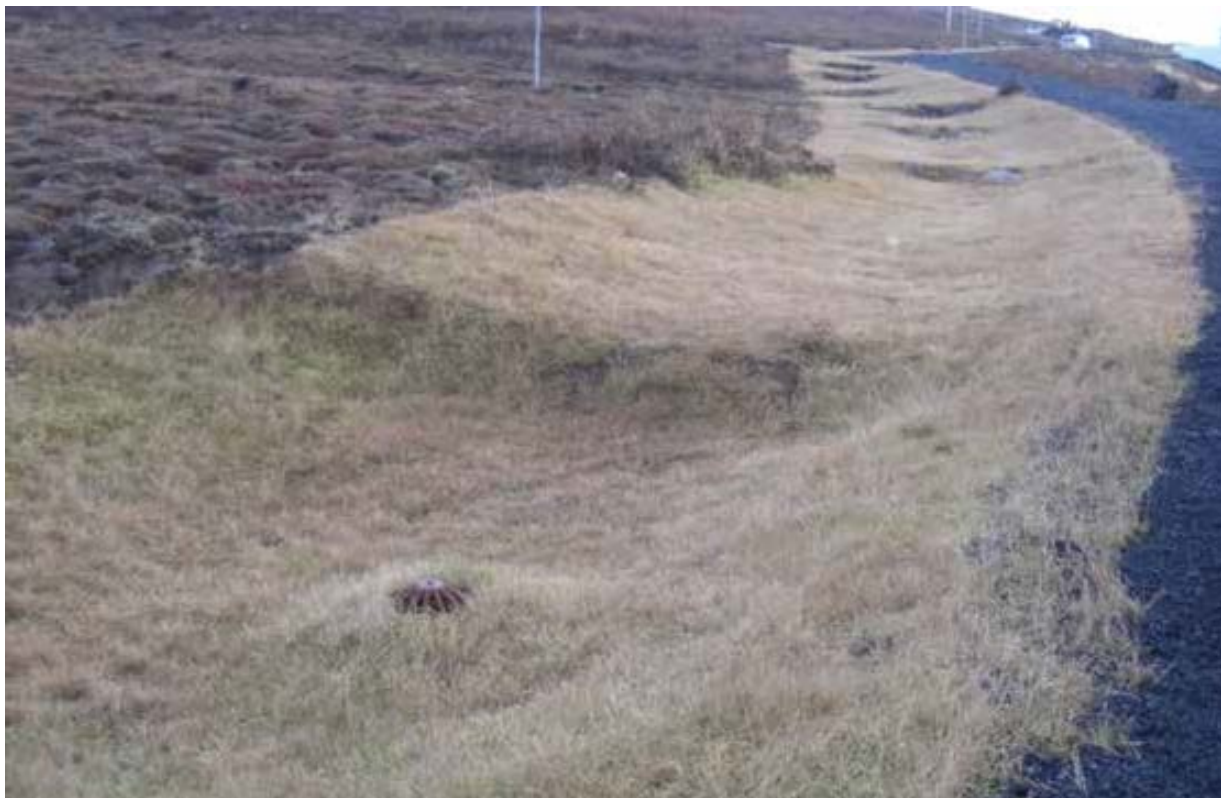
Figur 48. Gresskledd vannvei (og flomveg) på Urridaholt, Island. Tiltaket kombinerer bortledning av vann fra med størst mulig forsinkelse og fordrøyning underveis. (Leland, 2013).
