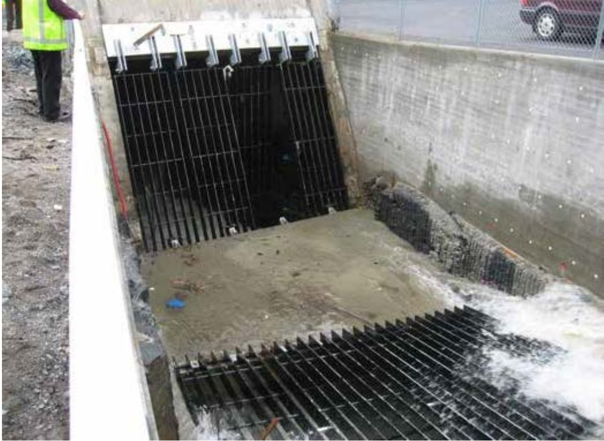
Figur 52. Inntaket til kulverten Alnaelva i Lodalen (Foto: Norconsult)
