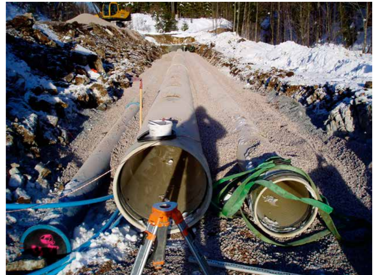
Ledningsanlegg med høydebasseng for Asker kommune og Gitrevannverket anskaffet som byggherrestyrt delte enterpriser.
