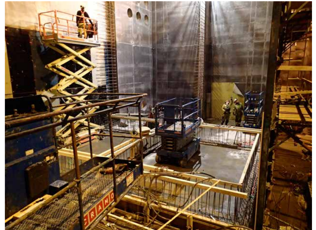
Oppgradering av Ytre Sandviken avløpsrenseanlegg. Prosessanlegget ble sammen med Holen, Kvernevik og Flesland anskaffet som totalentreprise. Foto: Bergen kommune
