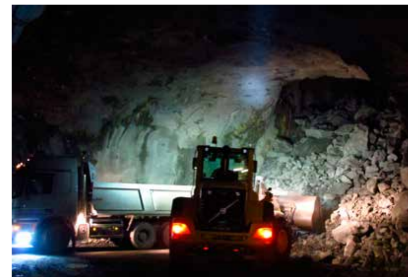
Oppgradering av Kvernevik avløpsrenseanlegg. Prosessanlegget ble anskaffet som totalentreprise mens fjellanlegg bygg/tekniske fag ble anskaffet som delentrepriser. Foto: Bergen kommune
