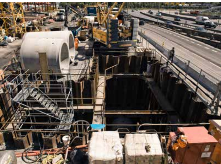
Midgardsormen med kostnadsramme på ca. 1.3 milliarder kroner ble anskaffet som byggherrestyrte delte entrepriser. Foto: Vann- og avløpsetaten, Oslo kommune
