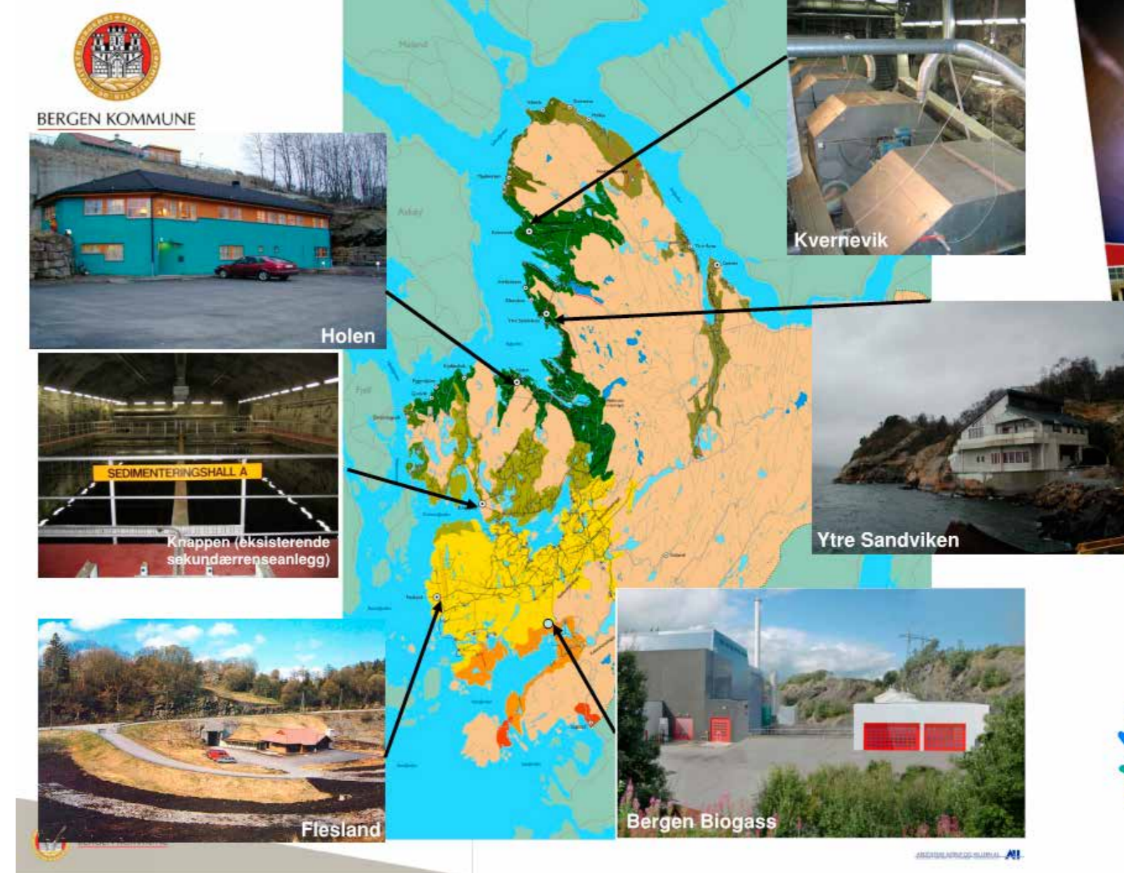
Oversikt over avløpsrensaneanlegg og biogassanlegg Bergen. Figur: Bergen kommune
