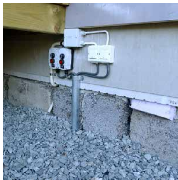
Alarm for høyt vann-nivå. (Foto: Bioforsk)
