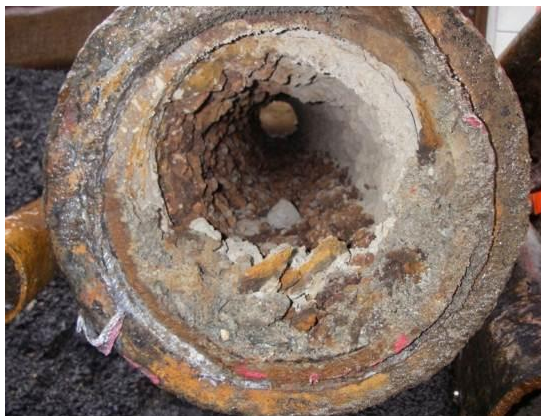
Figur 2. Ledning av grått støpejern som har blitt skiftet ut (Foto: SINTEF)
