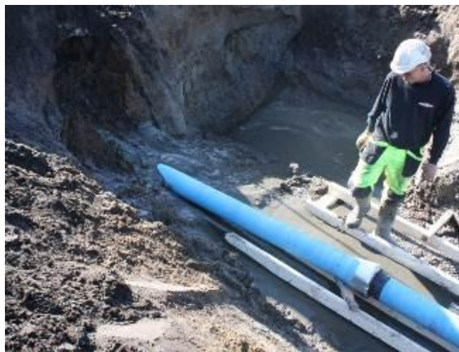
Figur 48. Inntrekking av duktile støpejernsrør med strekkfaste skjøter (Foto: Asplan Viak as)
