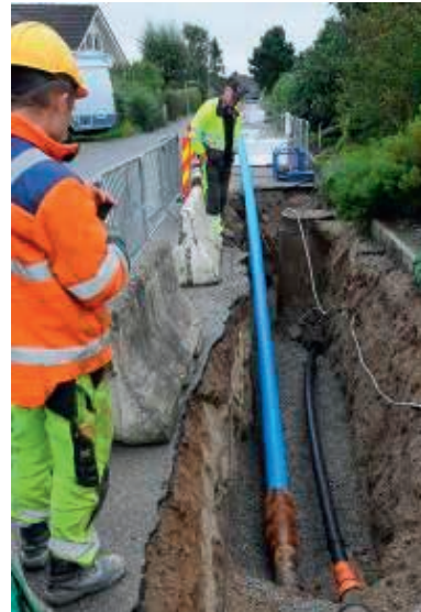
Figur 53. Utblokkerhodet er påmontert PE-røret og inntrekking starter
