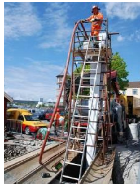
Figur 55. Strømpe installeres ved innvregning med vanntrykk. (Foto: Olimb as)
