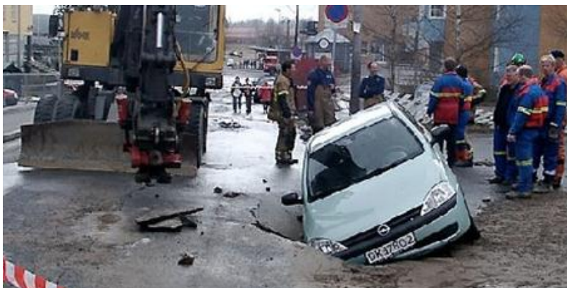
Figur 38. Følgeskader for trafikk i etterkant av vannledningsbrudd
