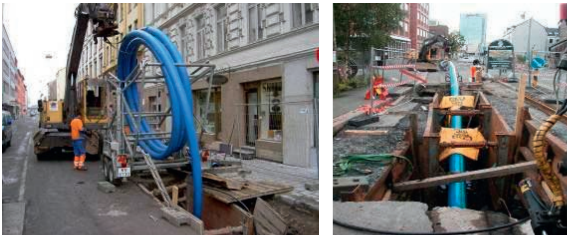
Figur 59. Innføring av PE-rør. I trange byområder kan det være smart å kveile PE-røret på kveilvogn, for å unngå beslagleggelse av verdifullt areal.
