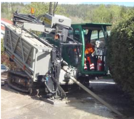
Figur 47. Borerigg under fremføring av pilotstreng. (Foto: Asplan Viak as)
