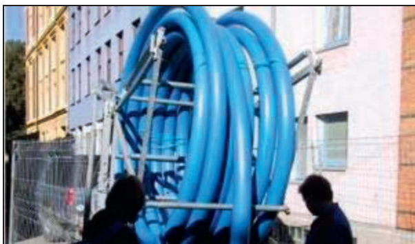
Figur 49. Innføring av PE-rør på kveil. (Foto: Asplan Viak as)
