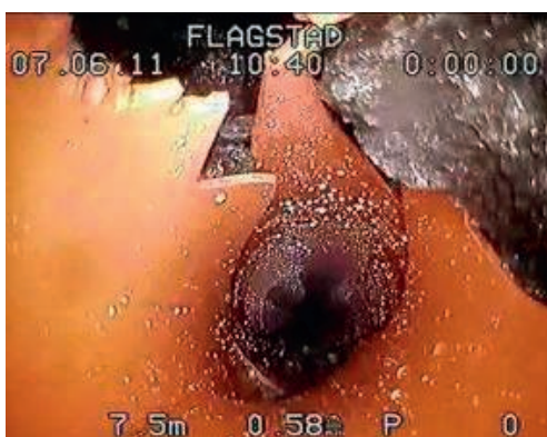
Figur 60. Enkeltfeil i avløpsnett blir punktrepasert (Foto: Flagstad as).
