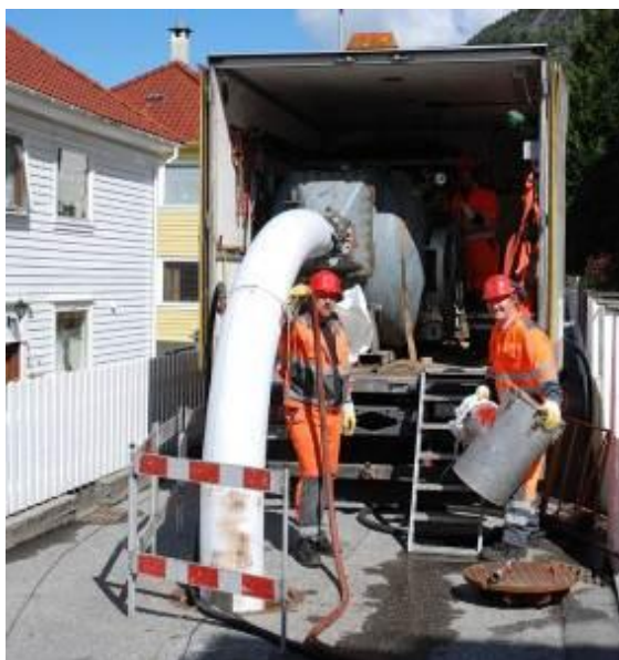
Figur 54. Strømpe installeres ved innvregning med trykkluft. (Foto: Olimb as)
