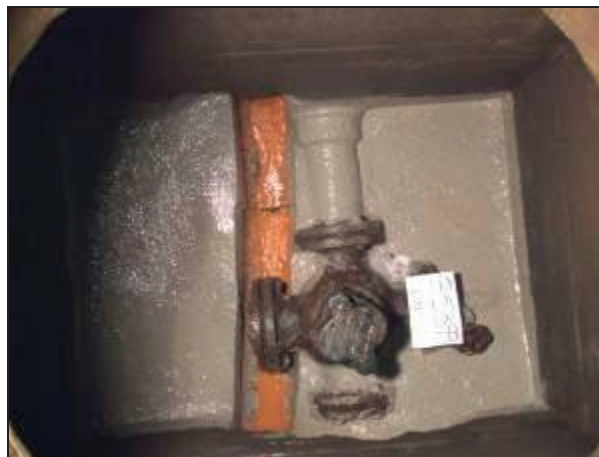
Figur 34. Eksempel på samme kum etter rehabilitering (Foto: NoDig NOR as)
