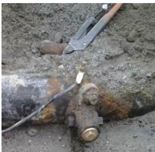
Figur 61. Til v.: Det registreres ofte vannlekkasjer i forbindelse med gamle anboringsklammer. Til h.: Begroing i 40 år gammelt galvanisert stålrør (Foto: Asplan Viak as/ Devegg Ruud).
