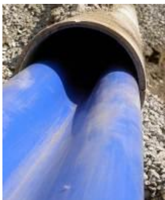
Figur 64. Konkurranse mellom CompactPipe og utblokking (Foto: Asplan Viak as).
