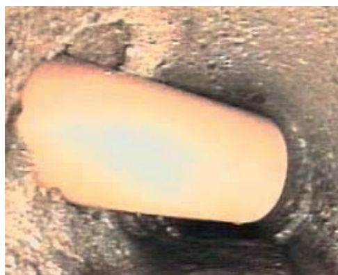
Figur 60. Enkeltfeil i avløpsnett blir punktrepasert (Foto: Flagstad as).
