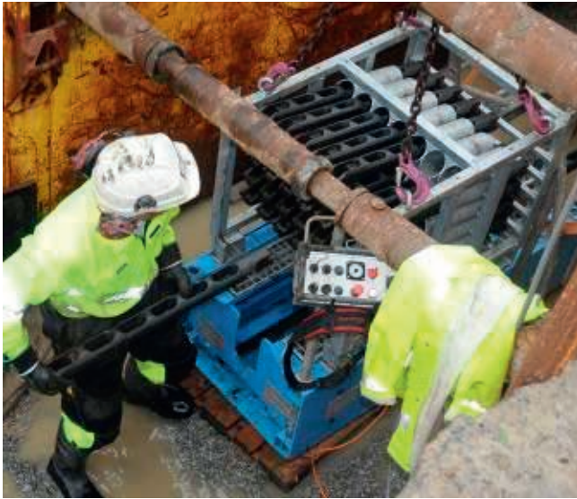
Figur 52. Innmating av trekkstenger i den gamle vannledningen. (Begge foto: Asplan Viak as)
