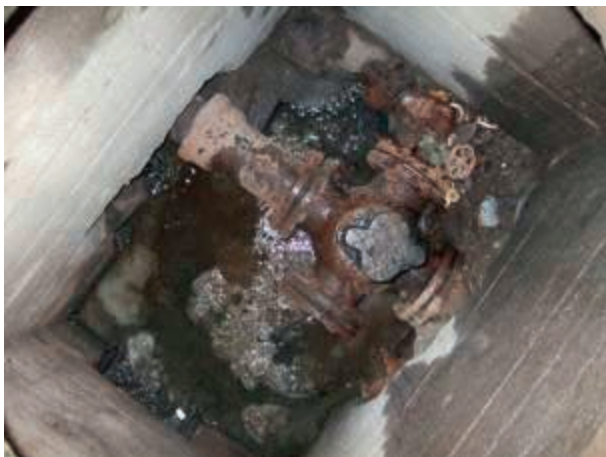
Figur 33. Eksempel på felleskum før rehabilitering (Foto: Asplan Viak as)
