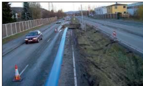
Figur 50. Innføring av helsveiset PE-rør, lengde 1000 meter (Foto: Asplan Viak as)
